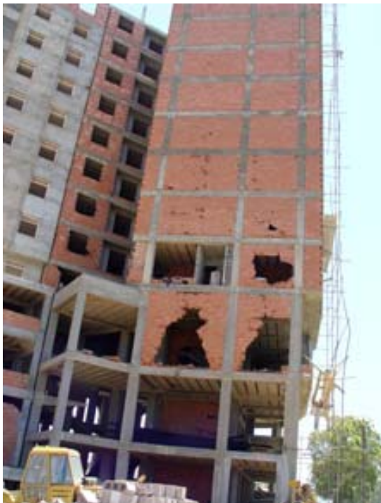
Figure 5.12. Bon comportement d'un bâtiment à noyau (structure primaire) et ossature périphérique (structure secondaire). (Boumerdes,2003).
