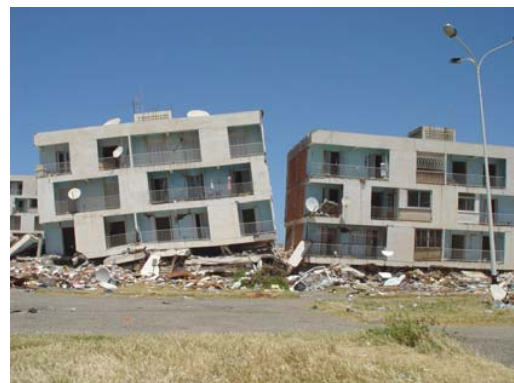
Figure 5.11. Création de transparence et ruine d'étage (ici le rez de chaussée).
