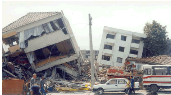
Figure 10.14. Effet de la formation de rotules plastiques dans les poteaux (Boumerdes, Algérie, 2003 - Kocaeli, Turquie, 1999)
