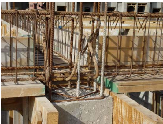
Figure 10.22. Absence d'armature transversale au nœud. Effondrement dû à cette absence au nœud et dans la zone critique du poteau.
