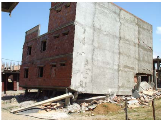
Figure 5.11. Création de transparence et ruine d'étage (ici le rez de chaussée).
