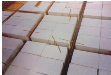
Figure 25 : Aspect des caissons allégeant configurés avec 6 blocs
