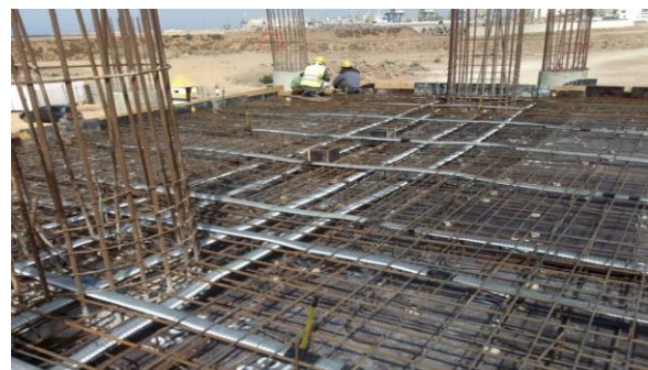
68 Figure 18 : Exemple d'une dalle précontrainte post tension
