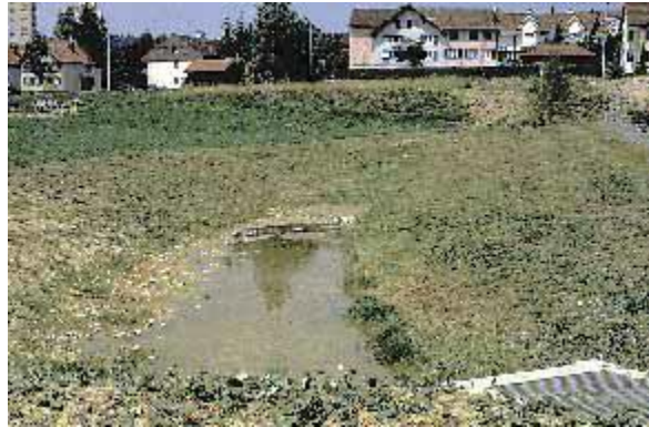
Figure 31: Bassin de rétention infiltrant
