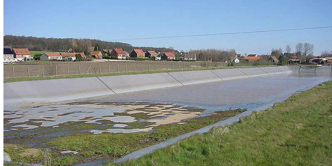
Figure 27: Bassin sec revêtu
