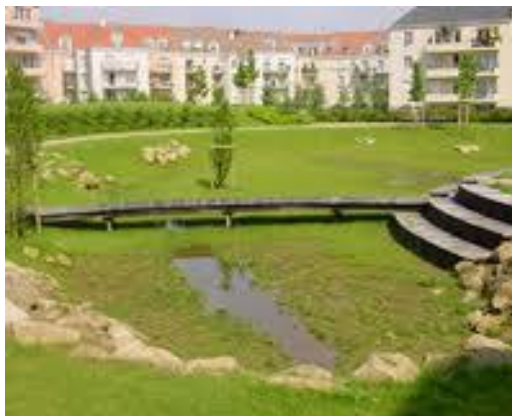
Figure 30: Bassin d'infiltration strict
