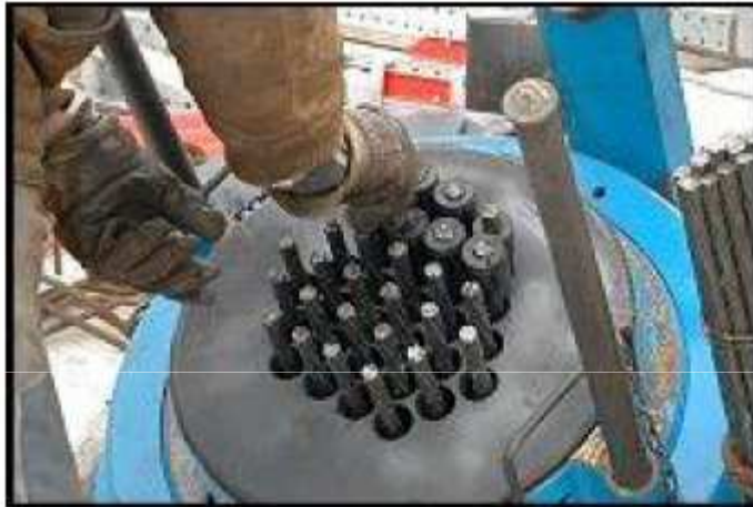
Câbles de précontrainte
