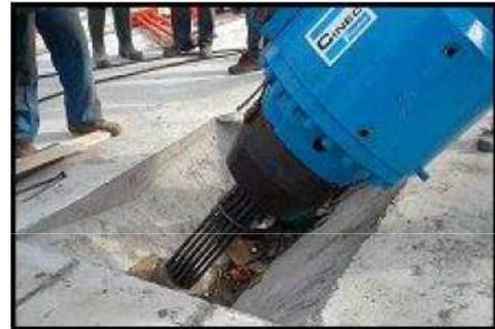
Mise en tension des câbles
