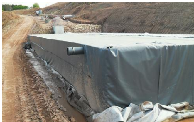
Figure 24 : Bassin enterré en béton armé
