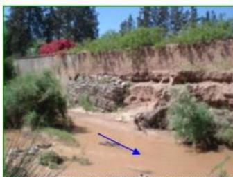
Rive gauche longée par des murs de clôture des fermes, protégée par endroit par gabionage
