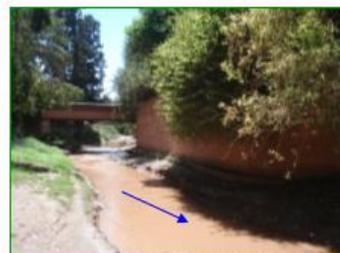
Pont permettant l'accès aux fermes, protégé par un mur sur les deux rives
