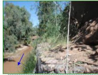
Protection de la rive droite par gabionage sur une longueur de 30m environ
