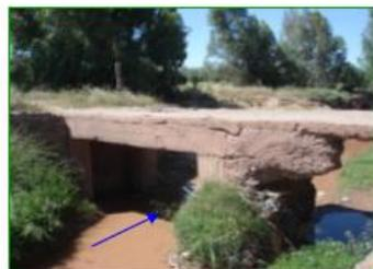
OH en état dégradé permettant l'accès aux fermes situées à l'amont de l'embou-
