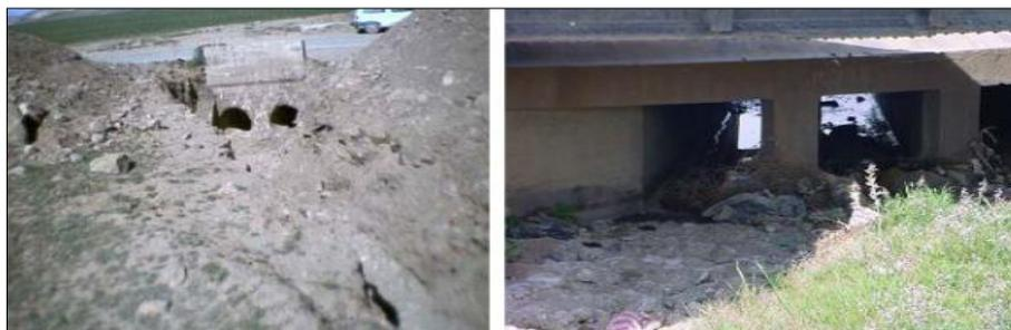
Figure 4 : Recalibrage des ouvrages d'art (à gauche : avant recalibrage/ à droite : après recalibrage)
