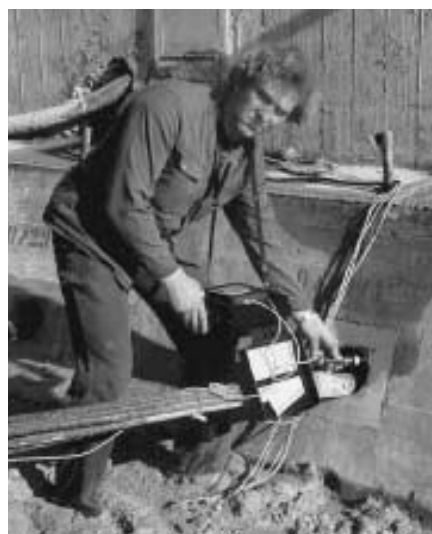
Mesure de la résistance d'un ancrage permanent
