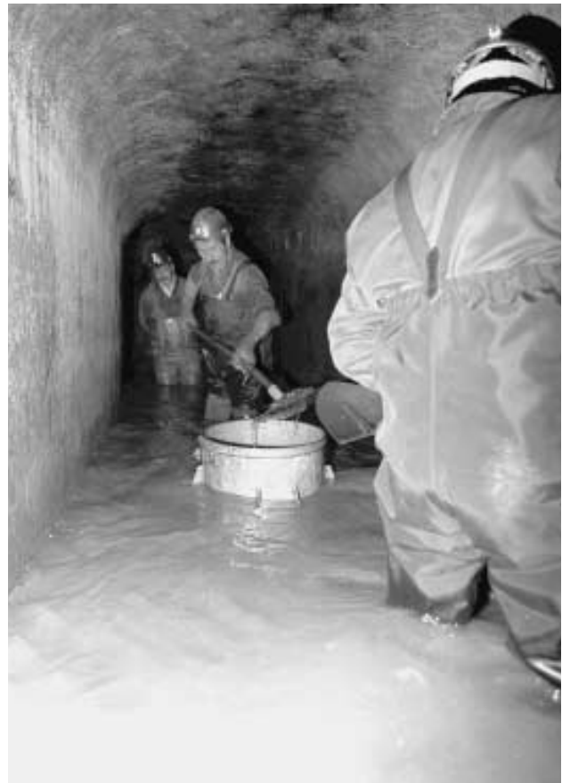
Visite d'une canalisation
