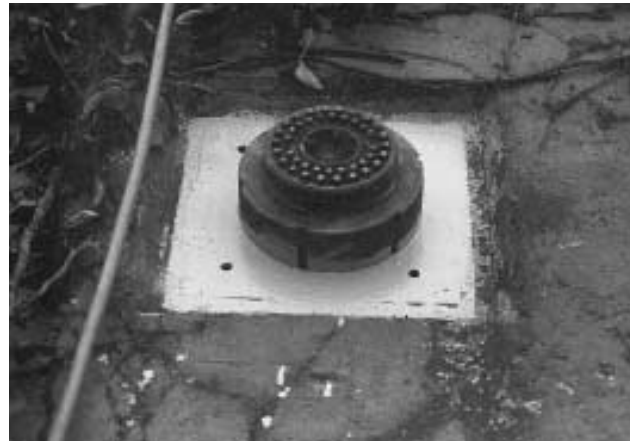
Tête d'ancrage dégagée et nettoyée
