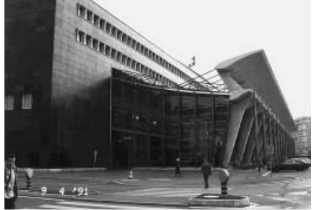
Nouvelle gare de Lucerne
