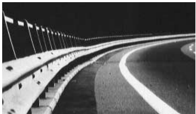
Déformations visibles d'un pont
