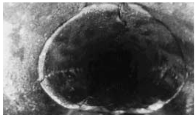
Images obtenues avec la caméra de télévision pour canalisations
