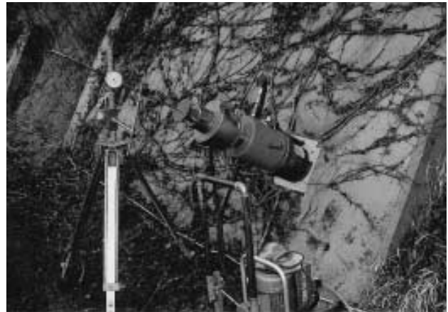
Mesure de la traction par essai de décollement
