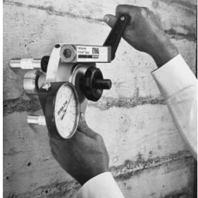
Essai d'arrachement in situ
