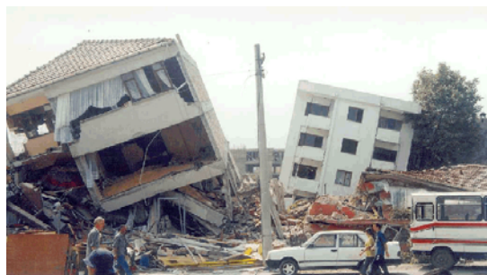
Figure 10.14. Effet de la formation de rotules plastiques dans les poteaux (Boumerdes, Algérie, 2003 - Kocaeli, Turquie, 1999)
