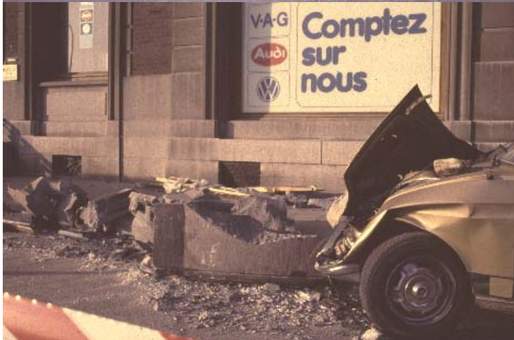
Figure 5.32. Chute de garniture en pierre. En haut, centre ville ; en bas Quai de Rome (Liège, 1983).
