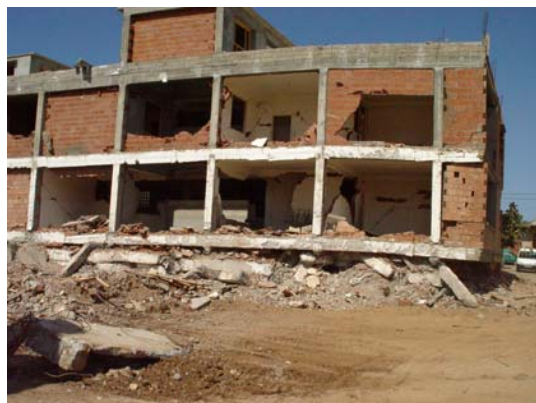
Figure 10.14. Effet de la formation de rotules plastiques dans les poteaux (Boumerdes, Algérie, 2003 - Kocaeli, Turquie, 1999)
