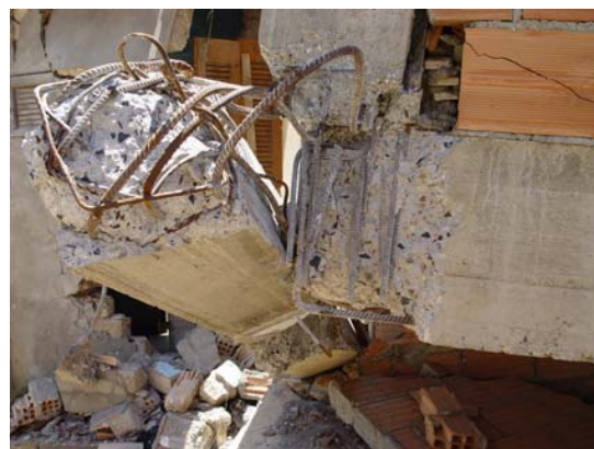
Figure 10.22. Absence d'armature transversale au nœud. Effondrement dû à cette absence au nœud et dans la zone critique du poteau.
