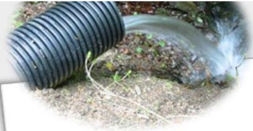
**Les réseaux de collecte** ont pour fonction de recueillir et **de transporter** les eaux usées et/ou pluviales. Ils sont constitués de canalisations généralement en fonte, PVC ou ciment et leur diamètre varie en fonction du débit des effluents à transporter.
