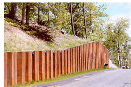
stabilisation de pente
