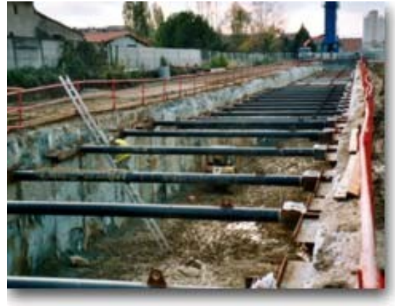
Figure 1.9 : Utilisation de butons en tranchée
