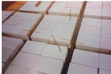
**Figure 25 : Aspect des caissons allégeant configurés avec 6 blocs**
