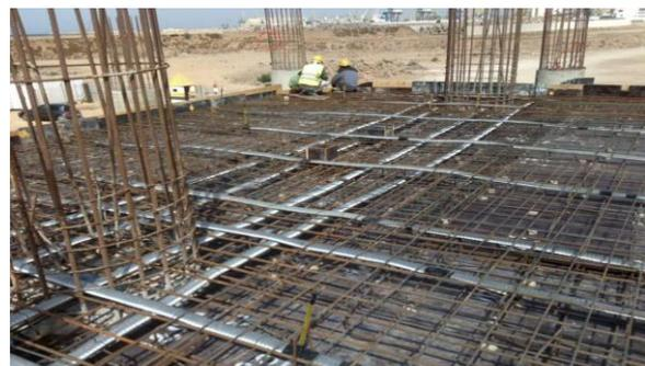
68 **Figure 18 : Exemple d'une dalle précontrainte post tension**
