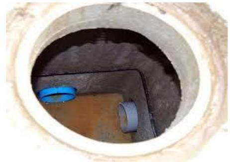
**2- Regard chute** : ce sont des regards analogues aux regards de visite, seulement la chute est plus importante, ce type de regard est prévu lorsque les canalisations sont disposées en forte pente, ce qui entraîne des vitesses très importantes, la chute des effluents dans ces regards permet de briser la vitesse d'écoulement.
