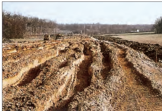
Comportement à la mise en remblai
