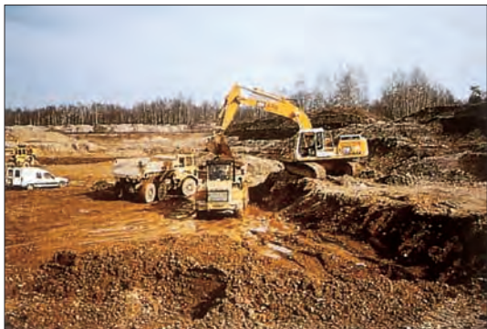
Extraction après rabattement de la nappe
