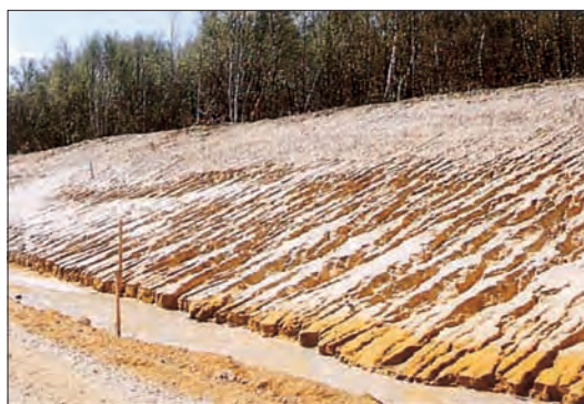
La portance des sables fins des classes B 1 ou D 1 est quasi-indépendante de leur teneur en eau mais ces sols sont en revanche très sensibles à l'érosion pluviale.
