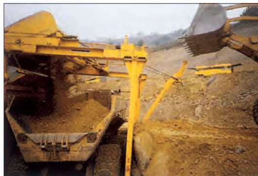
Ejection des éléments grossiers par basculement de la grille actionnée par le godet du chargeur au cours de sa marche arrière.
