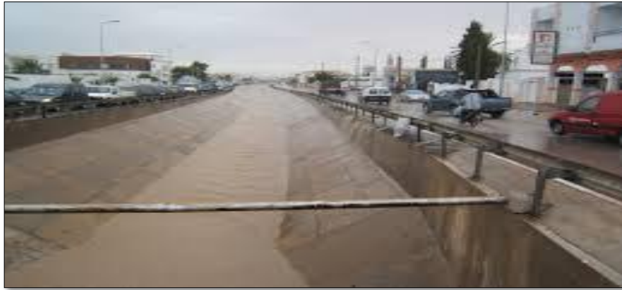
Figure 4 : La réalisation de canaux (c)
