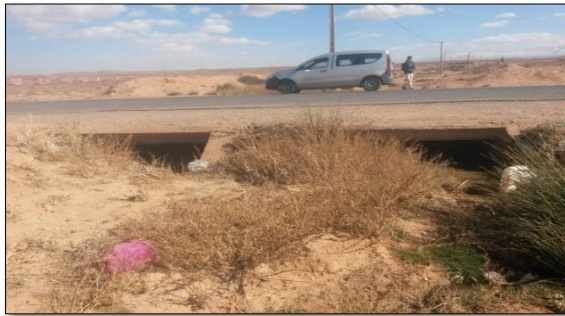
Figure 14 : Dalot à deux ouvertures
