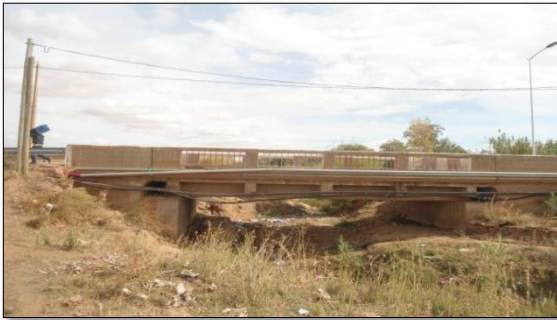
Figure 11 : Ouvrage sur Oued Bouhafs
