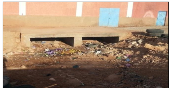
Figure 11 : Dalot à deux ouvertures
