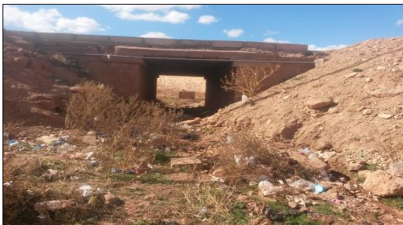
Figure 12 : Dalot existant sur Chaâba
