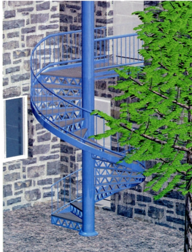
Figure 6.25 : Escalier extérieur métallique intégré au bâti
