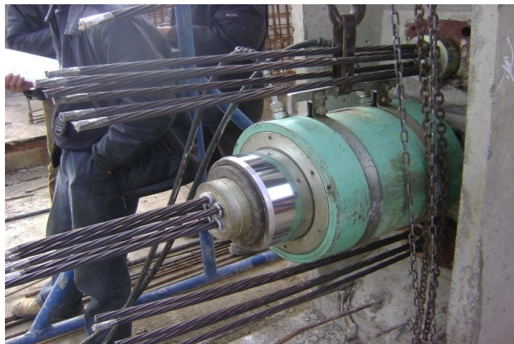
Figure I-8 : Vérin hydraulique.
