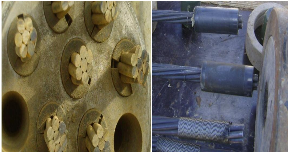
Figure I-5 : Les mors d'ancrage
