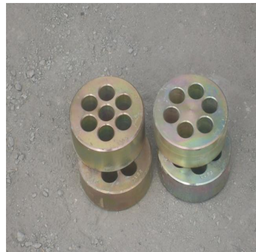
Figure I-4: Plaque d'ancrage (ancrage actif)
