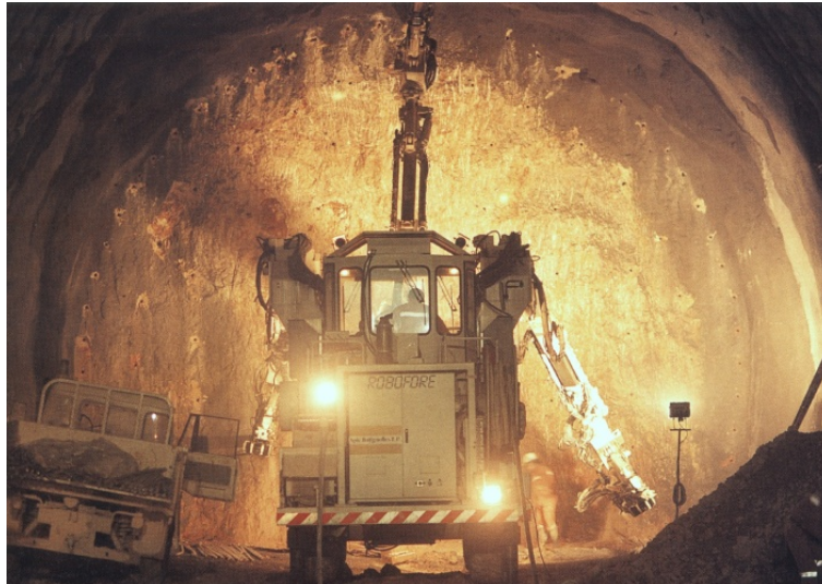
FIG. 1.3 – Jumbo au travail sur le tunnel des Pennes-Mirabeau (TGV Méditerranée). Doc Eiffage.
