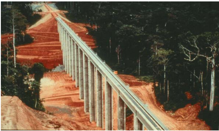
Viaduct en Cameroun utilisation de ciment avec fumée de silice importé du Canada - pour amélioration d'étanchéité
