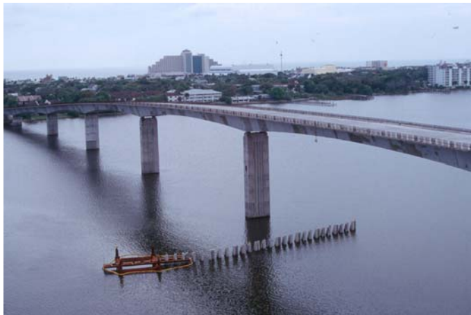
Causeway en Floride - Cendres volante utilisé pour augemente resistance à la penetration des ions chlore
