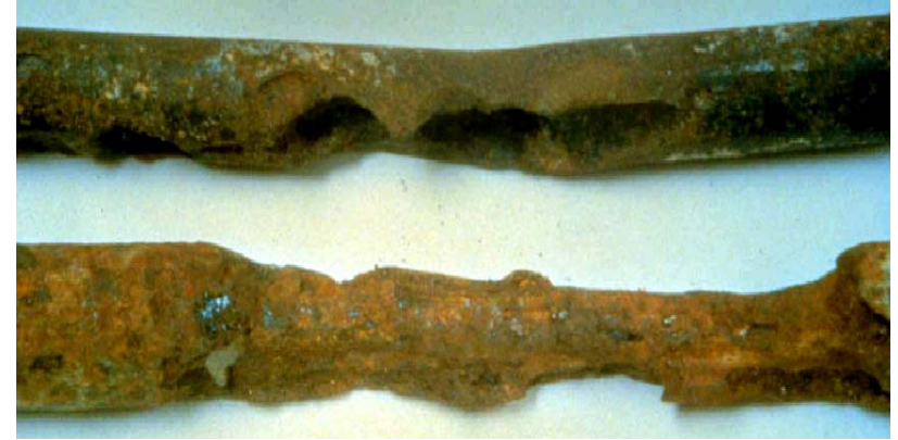
Piqûre profonde causée par une attaque de chlorure
