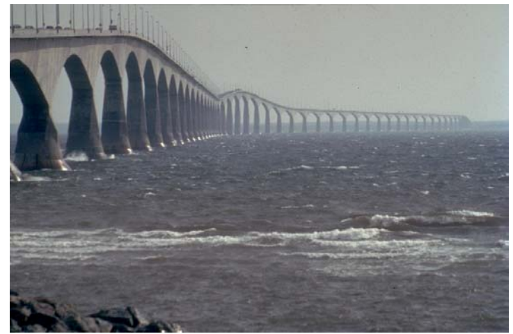
Confederation bridge, Canada: ciment+FS pré-mélangé +cendres volante ajouter à stage de fabrication du béton - pour augement durabilité, améliorer pompabilité, réduire chaleur, meilleur résistance
