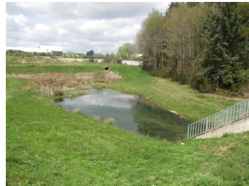
Bassin aérien en eau (Source OIEau)
