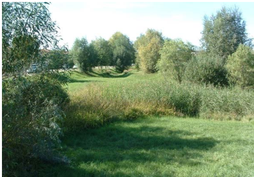
Bassin aérien sec (Source OIEau)
