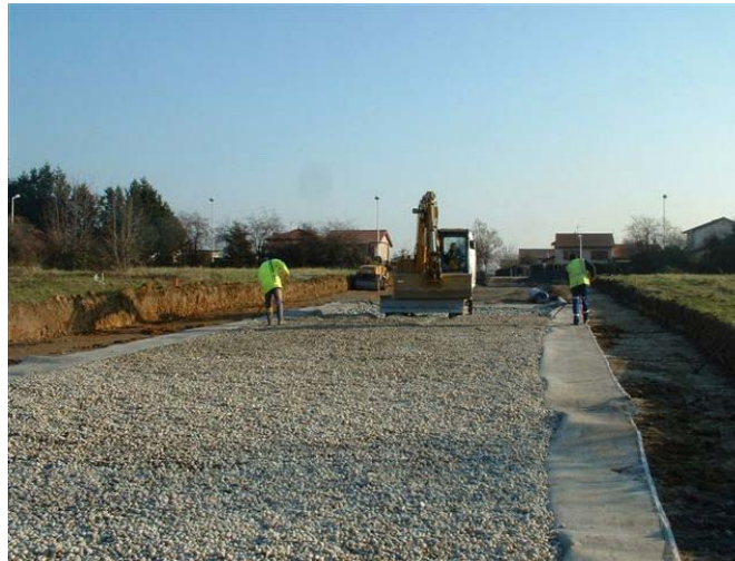
Figure 12: Structure réservoir sous voirie (Source Bonna-Sabla)
