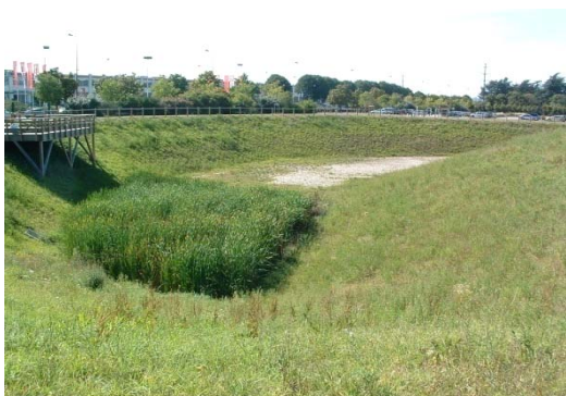
Bassin d'infiltration (Source OIEau)
