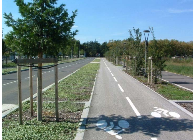
Figure 16: Voirie assainie par une tranchée couverte (Source OIEau)
