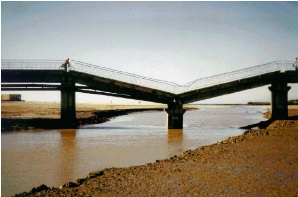
Figure 3: Enfoncement de la pile d'un pont
