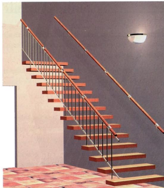
Figure 6.22 : Marches en console sur mur
