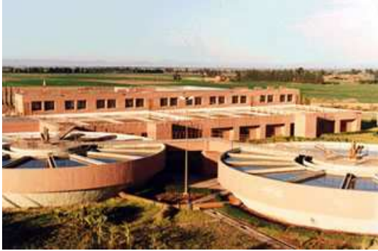
Station de traitement de Marrakech
