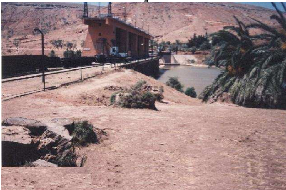
Usine ONE au barrage Sidi Said Maachou
