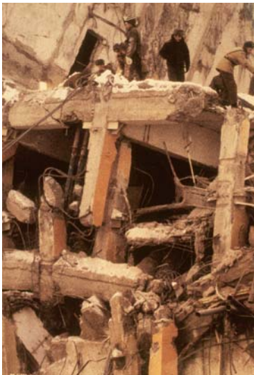
A gauche, le « chêne » : rupture fragile d'une structure de béton armé, au delà de la limite de résistance, c'est l'effondrement.
