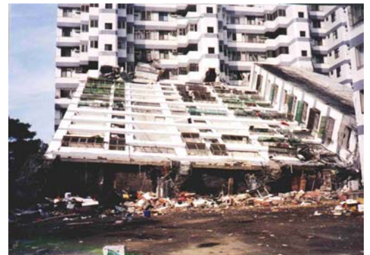
Désolidarisation des façades, destruction des étages supérieurs, intermédiaires ou inférieurs
