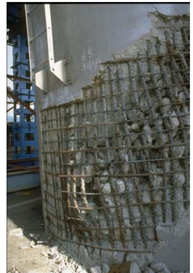
A gauche, le « chêne » : rupture fragile d'une structure de béton armé, au delà de la limite de résistance, c'est l'effondrement.
