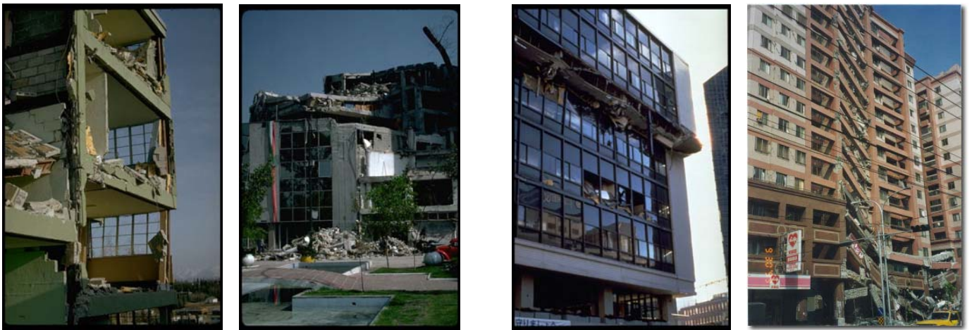
Désolidarisation des façades, destruction des étages supérieurs, intermédiaires ou inférieurs
