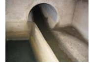
Déversoir d'orage avec éjecteur à trois lames intégré dans le déversoir de traitement.
