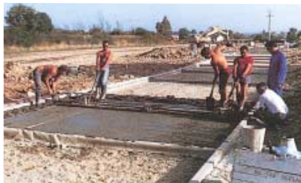
Serrage à la règle vibrante...
