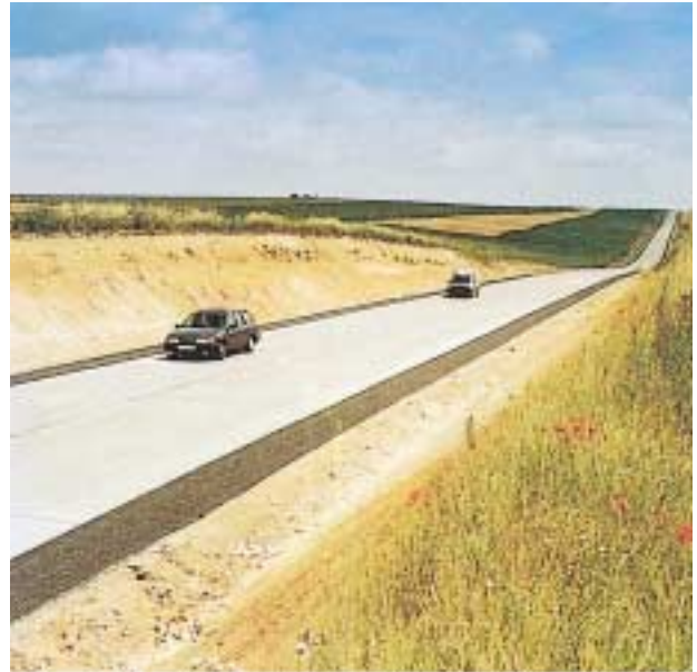
Chaussée épaisse en dalles courtes non armées.
