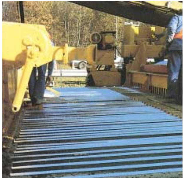
Béton armé continu : armatures en fer rond ou en ruban cranté.
