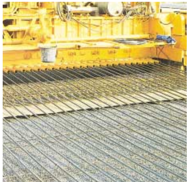
Béton armé continu : armatures en fer rond ou en ruban cranté.
