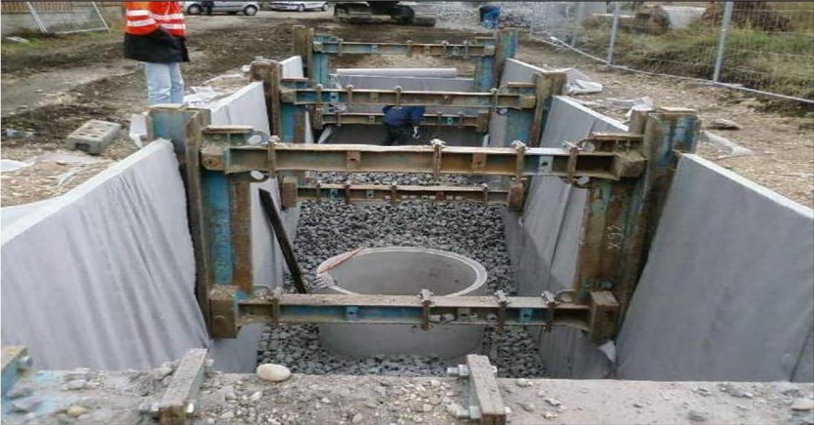
Figure 24: Exemple de bassin enterré en cours de réalisation
