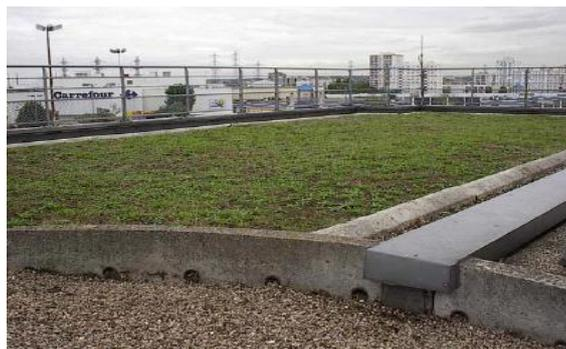
Figure 15: Photo d'une toiture en terrasse ou toit vert
