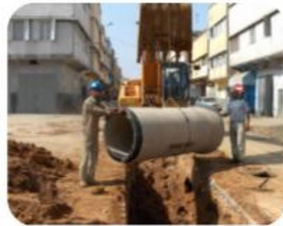
**Figure 4: Travaux de la RAK (source : site internet de la RAK)**
