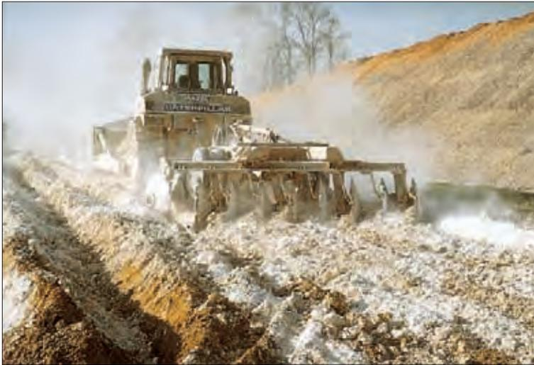
*Dans la technique du traitement à la chaux vive des sols sensibles à l'eau, trop humides pour l'utilisation en remblai, le malaxage s'exécute généralement avec des charrues. Les charrues à disques tractées telle que celle montrée sur la photo produisent une qualité de malaxage tout à fait satisfaisante pour cette nature de travaux mais leur profondeur de travail est faible (15 à 20 cm au maximum) et sujette à des variations non maîtrisables par le conducteur.*
