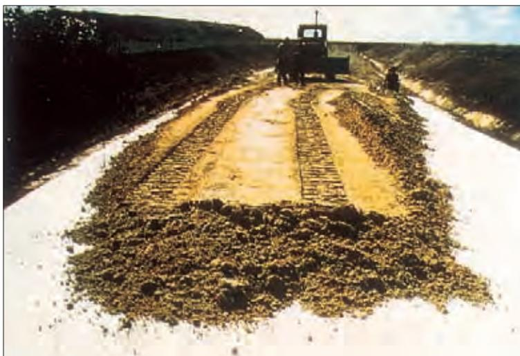
*L'intercalation d'un géotextile anti-contaminant entre une couche de forme en matériaux granulaires et un sol sensible à l'eau, humide permet de sauvegarder les caractéristiques du matériau granulaire et de réduire ainsi l'épaisseur de la couche de forme.*
