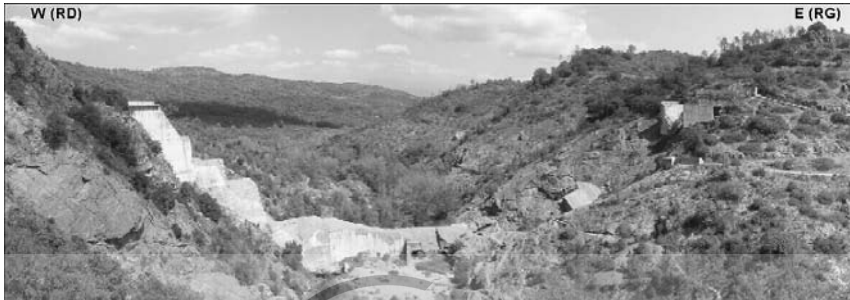
Photo 1.1.1.3.a – Les ruines du barrage de Malpasset vues de l’aval
