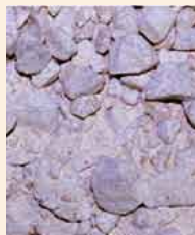
Matériau après essai
