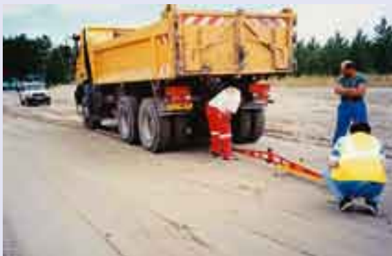
Plaque de diamètre 600 mm avec poutre Benkelman.
