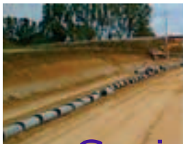
Tuyaux bardés sur chantier
