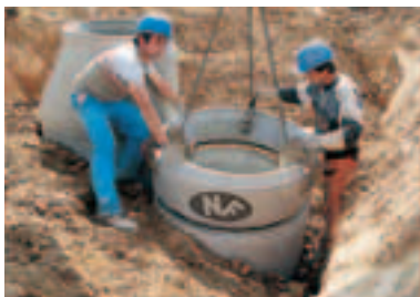
Installation d'un regard sur chantier
