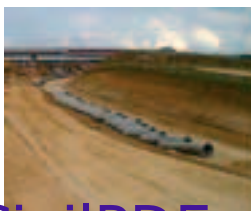
Tuyaux bardés sur chantier
