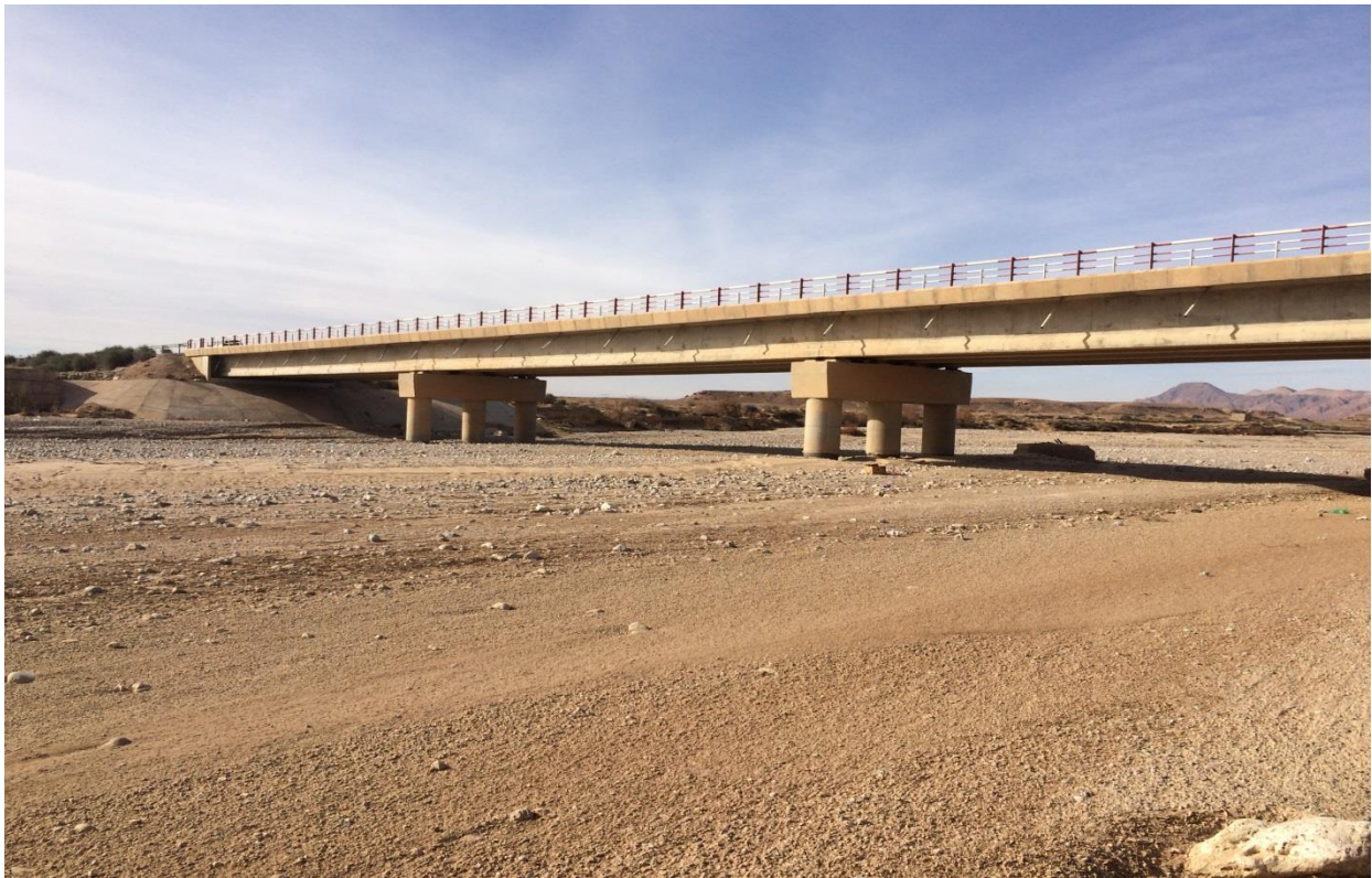
Figure 56: Vue du pont au niveau amont de l'oued Chouf Cherg
