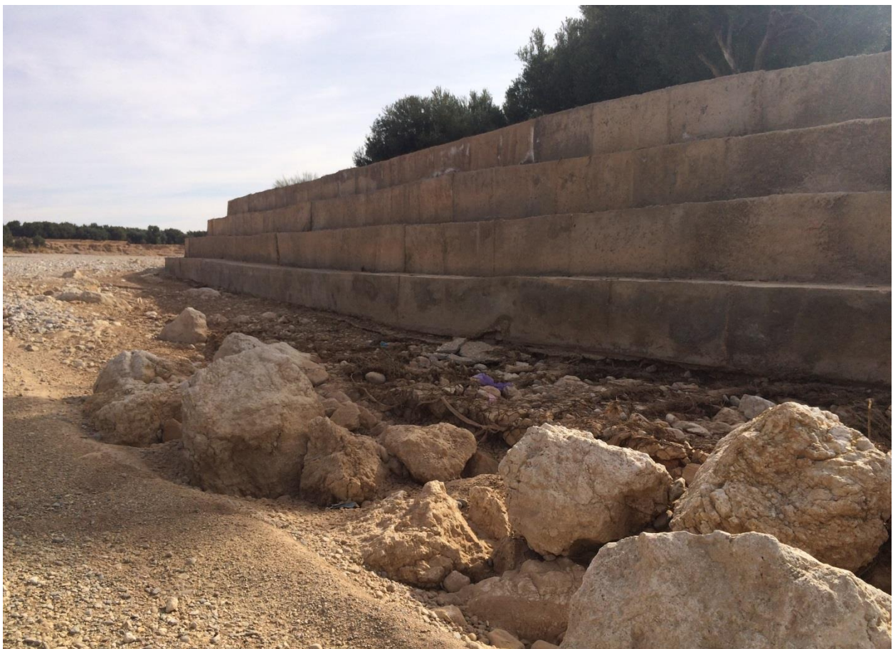
Figure 57: Aperçu des murs en gabion
