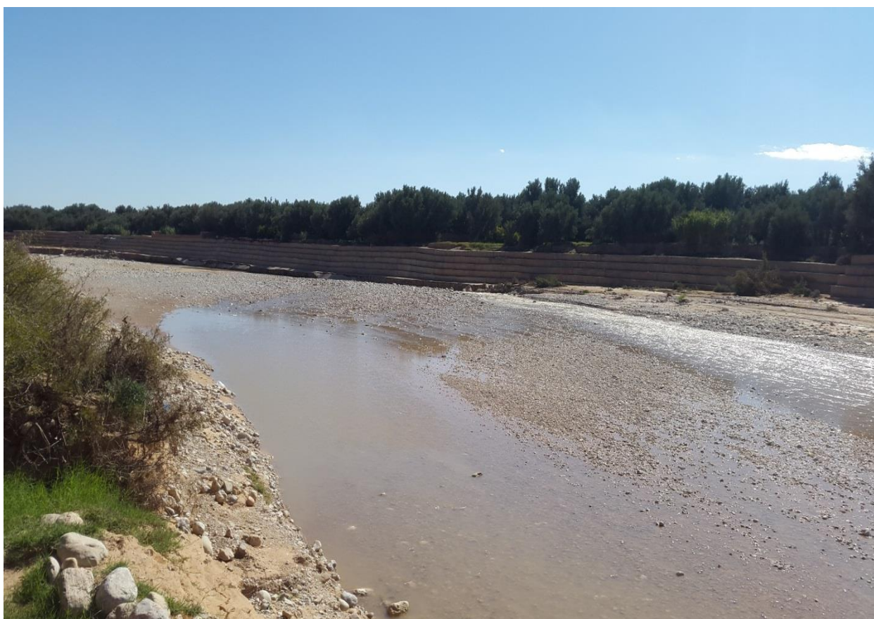
Figure 53: Aperçu d'un tronçon de l'oued Chouf Cherg
