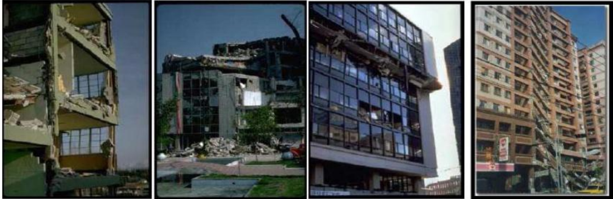
Fig.29 : Mode de ruine des constructions à l'effet du séisme
