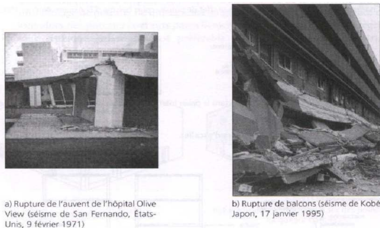
Fig. Dommages aux éléments en porte à faux (source [1])
