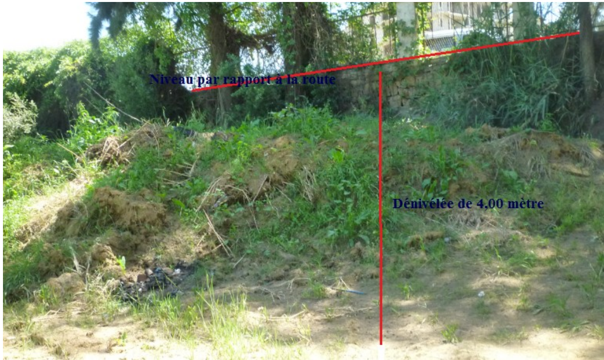
Photo II.2: Le terrain au cours du décapage du sol naturel
