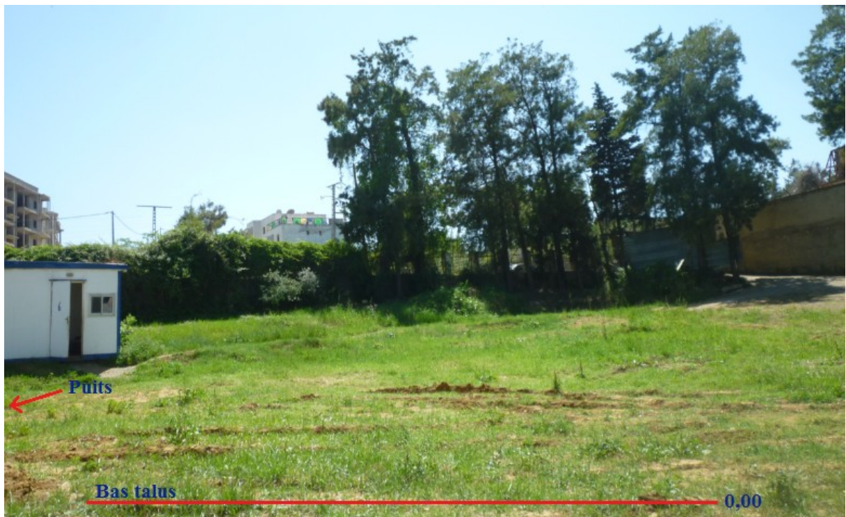
Photo II.3 : Le terrain après terrassement
