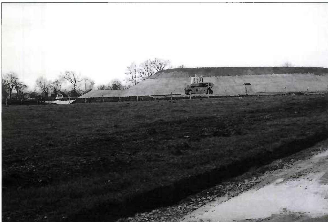
Autoroute A 89 – Section 1 – Remblai de préchargement de l'OHD 3 – LRPC Bordeaux.
