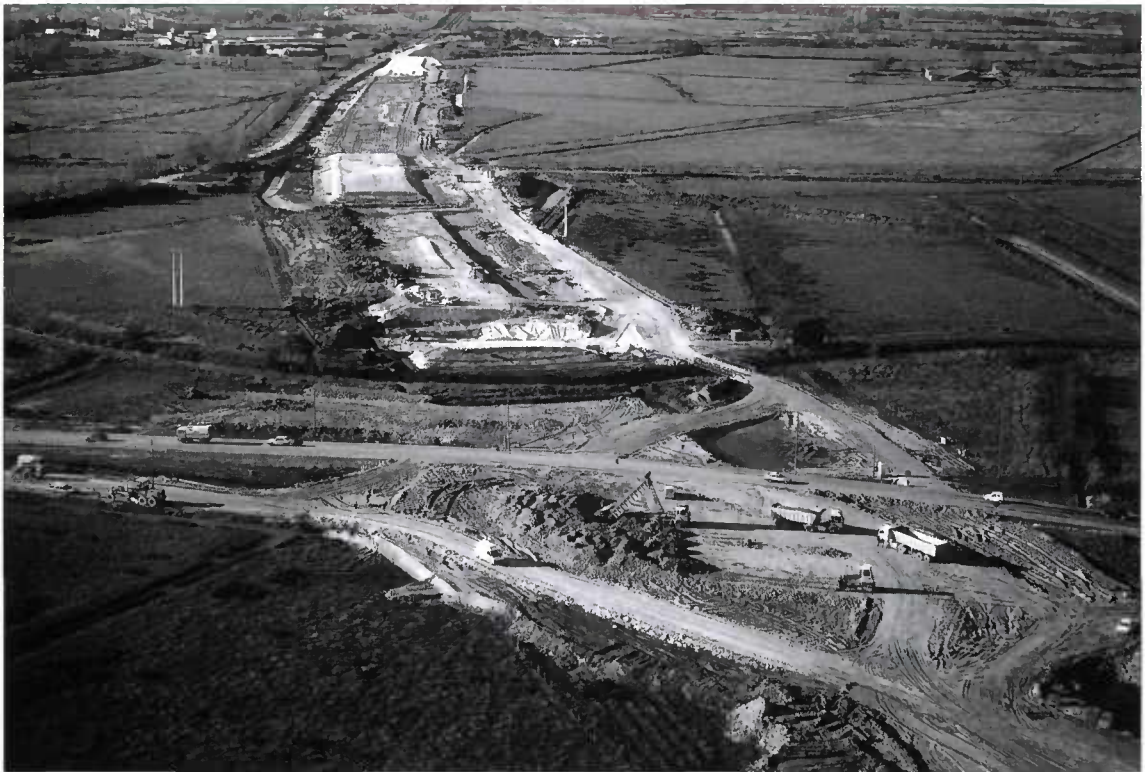
A 837 - Saintes-Rochefort - Zone de Rochefort-Tonnay-Charente - Autoroute en cours de construction - Scétauroute-ASF
