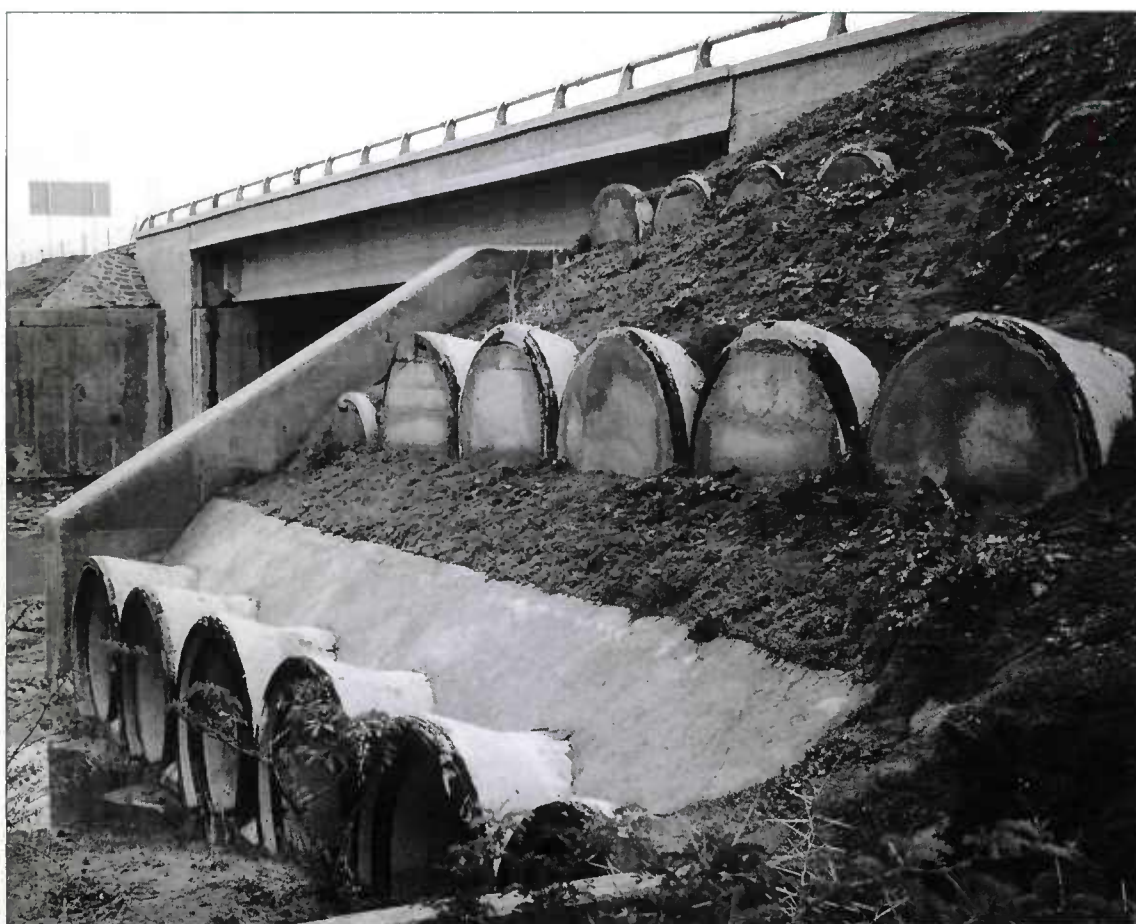
Remblai d'accès au pont sur le oued (Drader au Maroc) – Allègement au moyen de buses – LCPC
