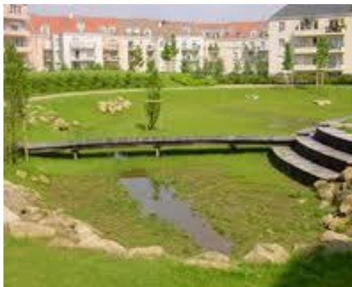
Figure 30: Bassin d'infiltration strict
