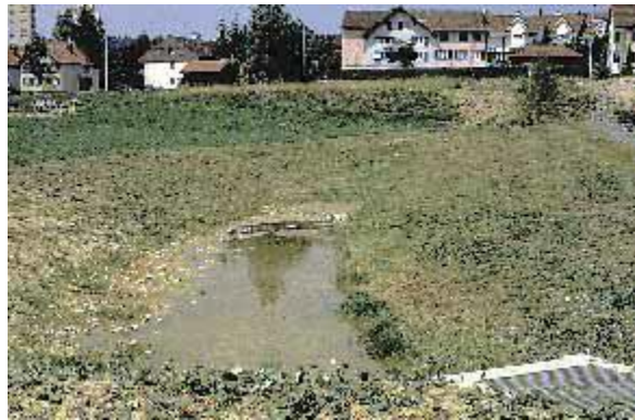
Figure 31: Bassin de rétention infiltrant
