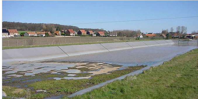
Figure 27: Bassin sec revêtu
