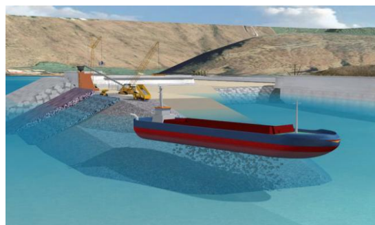
Figure 96 : Construction de la digue d'enclosure
