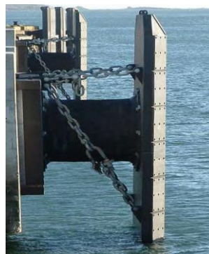
Figure 5 : Photo des défenses de type MCS 2250
