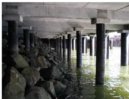
Figure 105 : Photo d'un quai sur pieux
