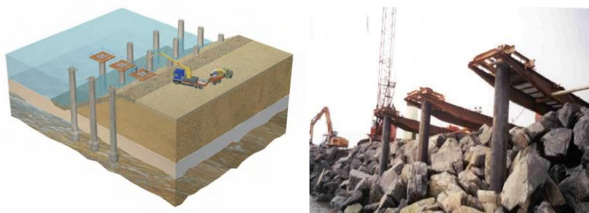
Figure 102 : Construction des chapiteaux
