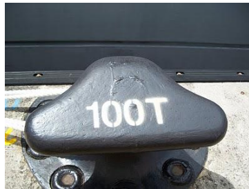
Figure 4 : Photo de bollard de 100 tonnes
