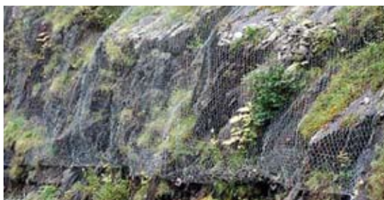
▲ Figure 70 : Talus revégétalisé et protégé par un grillage. [Cemagref]
