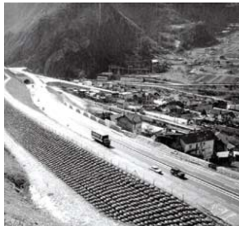
▲ Figure 27 : Exemple de merlon en pneutex sur la N90 en France (RiskYdrogé)
