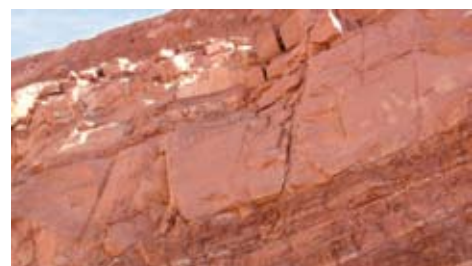
▲ Figure 90 : Série gréseuse fracturée du massif constitutif du déblai D15 [photo ADM]
