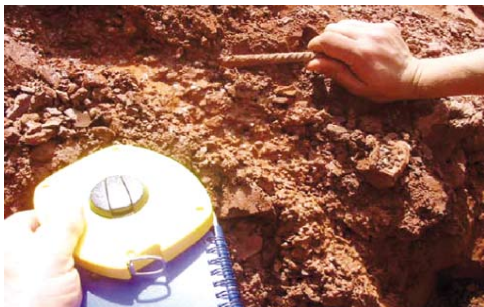
▲ Figure 99 : apparition d'eau au pied du déblai D15 vers son extrémité nord (avril-2010) [photo ADM]
