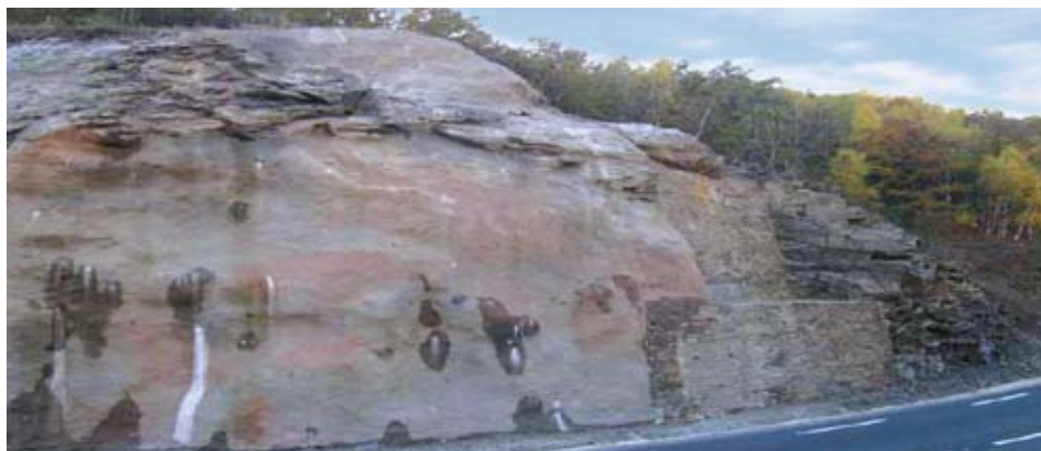
▲ Figure 57 : béton projeté et mur de protection contre l'érosion [Genois, CETE]
