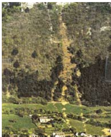
▲ Figure 68 : tranchée laissée dans la forêt par des gros blocs très énergétiques [RiskYdrogeo]
