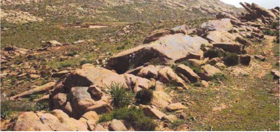
▲ Figure 97: Couronnement de la montagne sur laquelle est effectué le déblai D15 (mars-10) [photo ADM]
