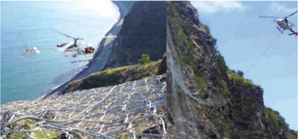
▲ Figure 35 : mise en place de nappes de grillage [Malascrabes, 2009]
