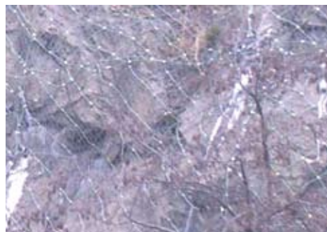
▲ Figure 59 : grillage derrière les filets plaqués [RiskYdrogeo]
