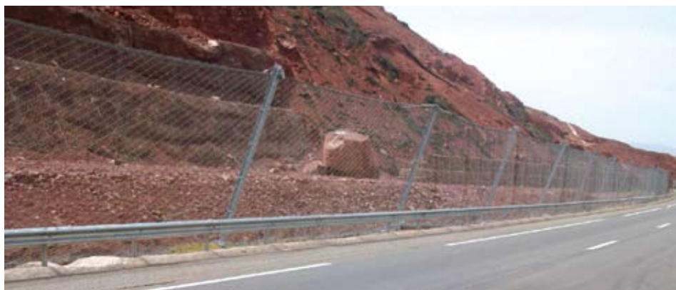
▲ Figure 41 : écrans à filets dynamiques [ADM, 2010]
