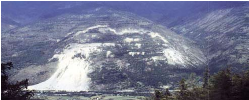
▲ Figure 9 : Glissement de La Clapière en 1986 [Co jean et al., 2002]
