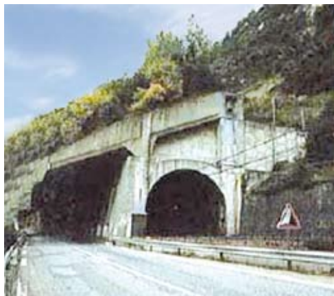
▲ Figure 47 : galerie de protection passive [Genois, CETE]
