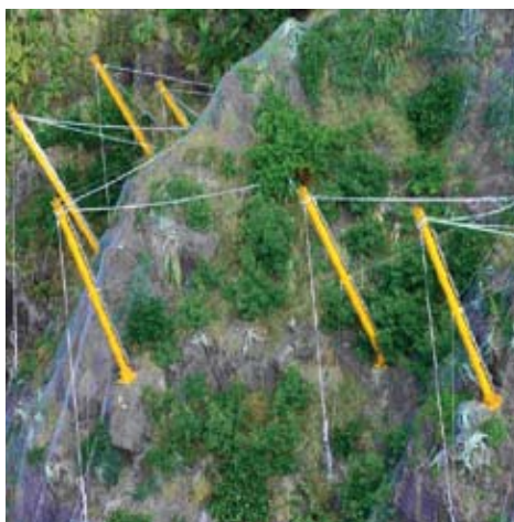
▲ Figure 44 : Mise en place d'ouvrages déflecteurs (poteaux et haubans) [Malascrabes, 2009]
