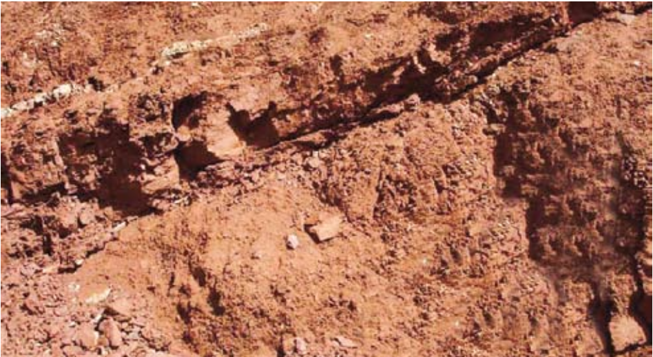
▲ Figure 95 : Détail de fracturation sur le déblai nord (20-mars-10).
