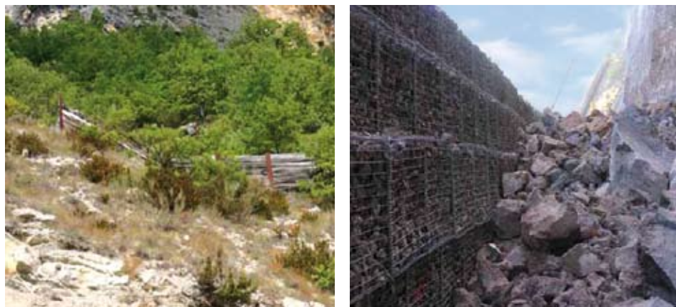
▲ Figure 32 : écran à structure souple (gauche) et rigide en gabions (à droite) [Genois, CETE]
