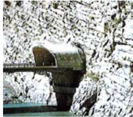
▲ Figure 50 : galerie de protection en voûte qui prolonge un tunnel [Genois, CETE]
