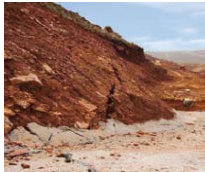
▲ Figure 86 : Déblai D15 - ligne de glissement dont la fissure traverse le replat (mars 2010) [Photos ADM]
