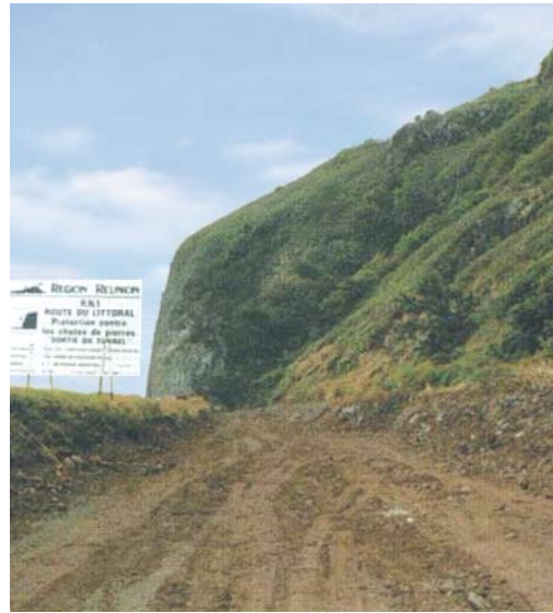
▲ Figure 30 : Fosse de réception aménagée en pied de falaise sur la RN dans l'île de la Réunion (RiskYdrogé)
