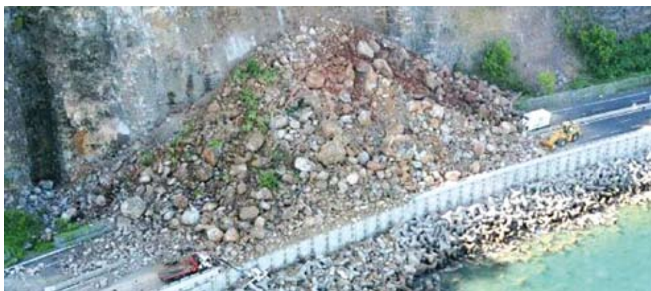
▲ Figure 5 : Eboulement sur voie routière [Garnier, 2010]
