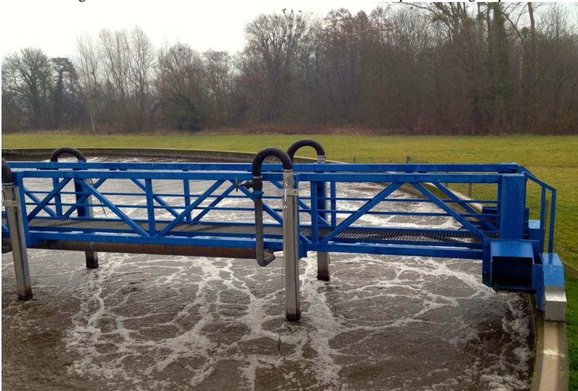
Figure 29 : Bassin d'aération
