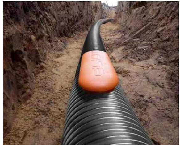
Figure 57: Capteurs de Géo référencement des canalisations
