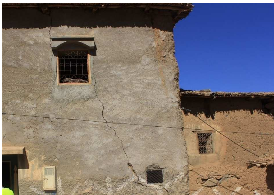
Fig. 39 : Fissuration inclinée à l'endroit des ouvertures dues à l'absence ou l'insuffisance des dispositifs de renforcement (Douar Afella Nouzgrouz, Iguidi, Taroudant)
