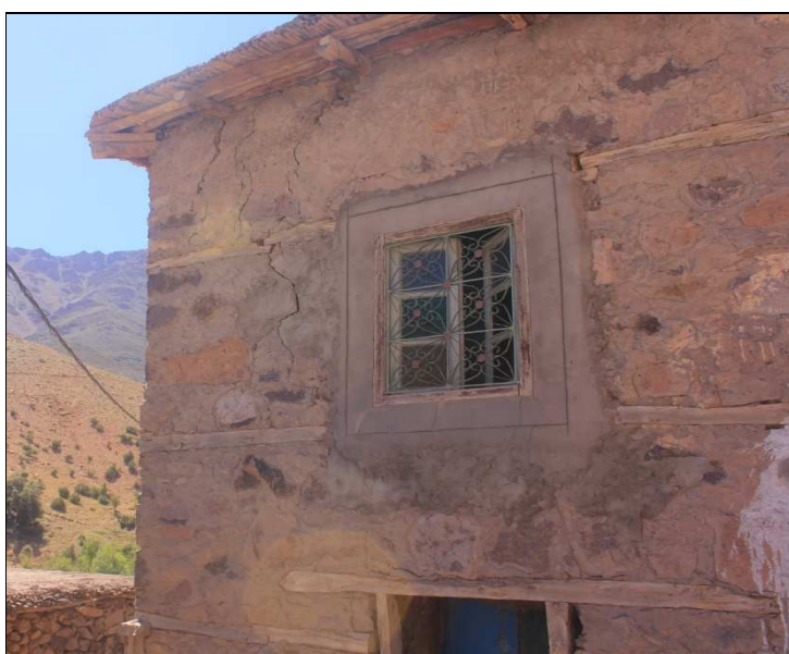
Fig. 26 : Technique de chaînage en bois massif local (Douar Afella Nouzgrouz, Iguidi, Taroudant)
