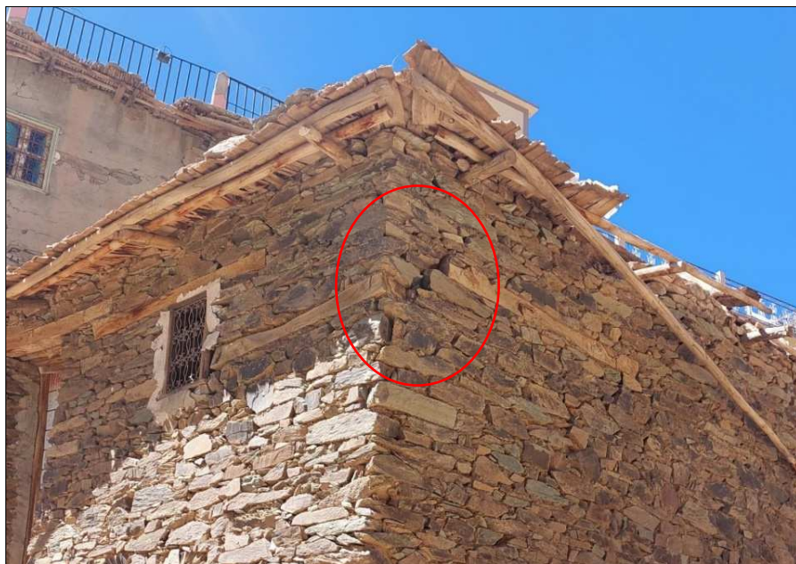
Fig. 40 : Recouvrement des éléments de chaînage en bois non assuré (Douar Amchkarjen, Ighil, Al Haouz)
