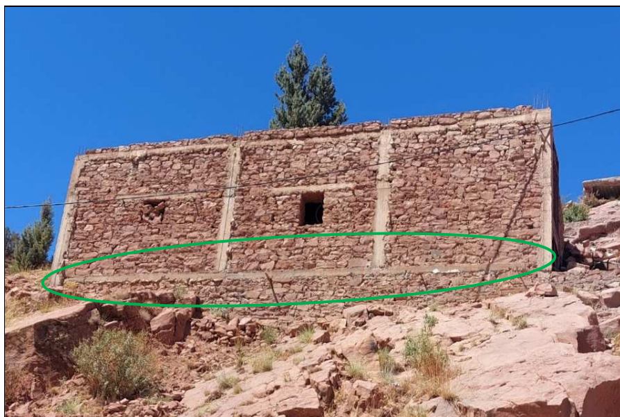
Fig. 32 : Exemple de soubassement réalisé avec chaînage (Ighil centre, Al Haouz)
