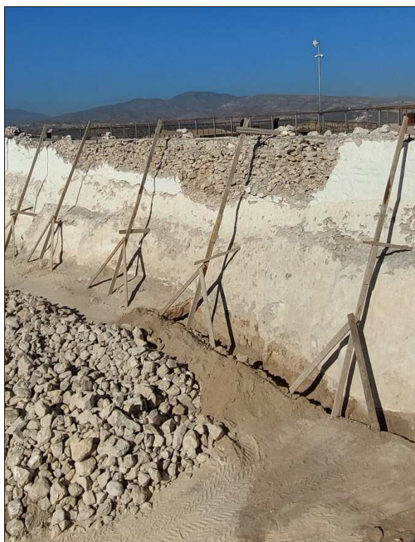
Irrégularités en élévation et qualité de mise en œuvre
