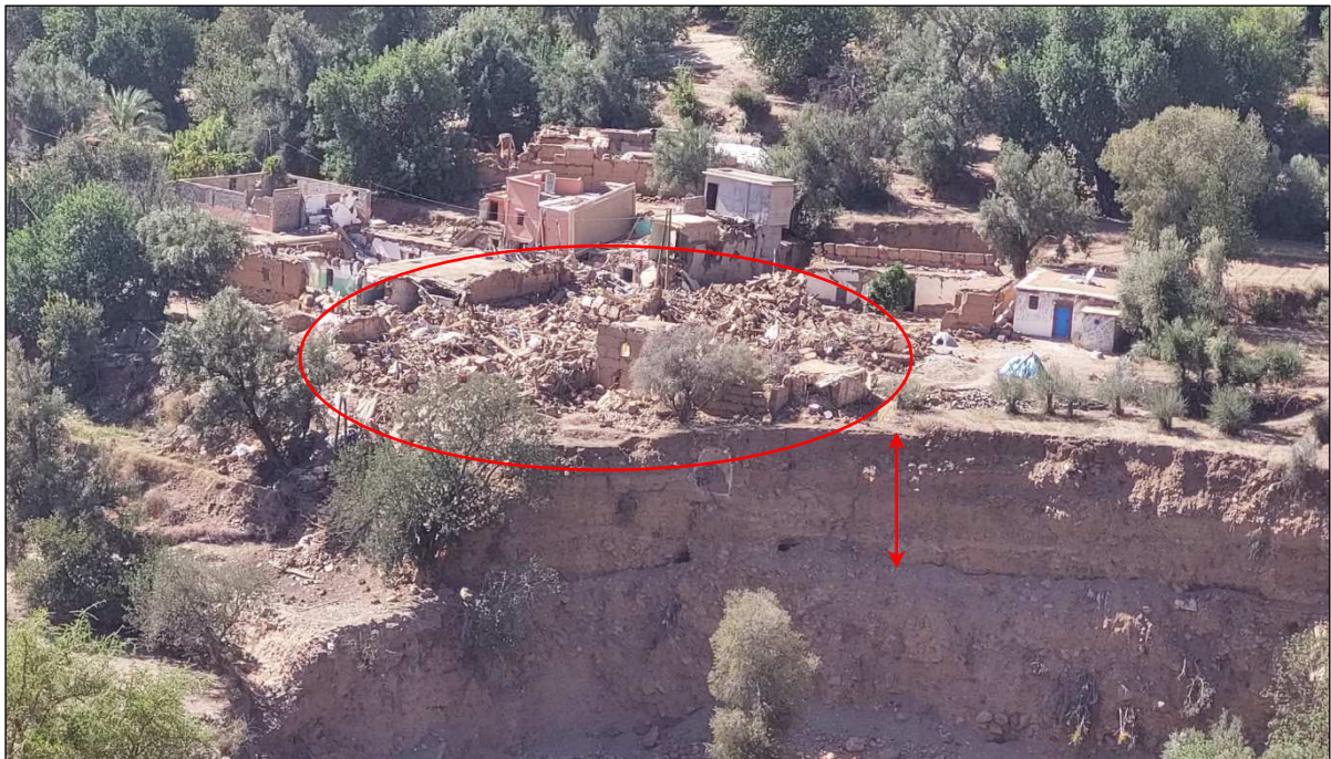
Fig. 14 : Effondrement total ou presque des anciennes constructions en terre réalisées sur sol relativement meuble (Douar Ait-Oublal, Tizi n'Tast, Al Haouz)
