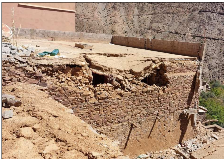
Fig. 43 : Exemple illustrant le rôle important du chaînage de couronnement des murs avant la pose du plancher-toiture
