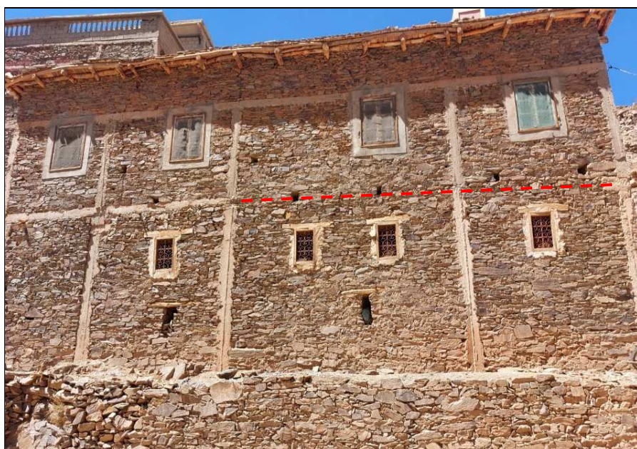
Fig. 41 : Continuité de chaînage en béton armé non assuré (Ighil Centre, Al Haouz)
