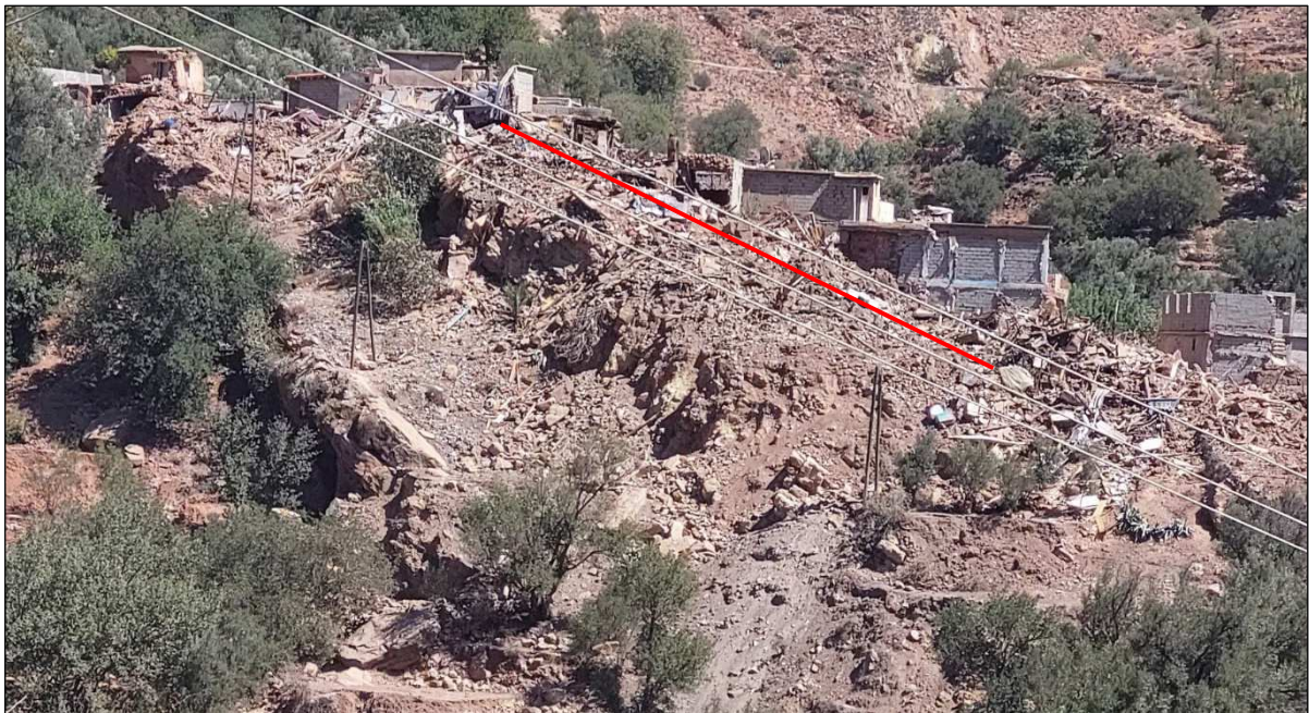
Fig. 13 : Effondrement total des anciennes constructions en terre réalisées sur pente rocheuse (Douar Tamsoult, Tizi n'Tast, Al Haouz)
