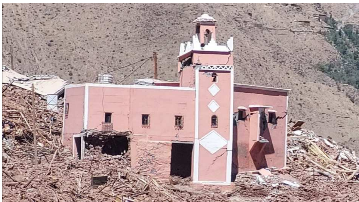
Fig. 18 : "L'isolation structurelle" des constructions a eu pour conséquence le fait que la plupart des mosquées ne se sont pas entièrement effondrées (Ici mosquée du douar Amerzagane, Ighil, Al Haouz)
