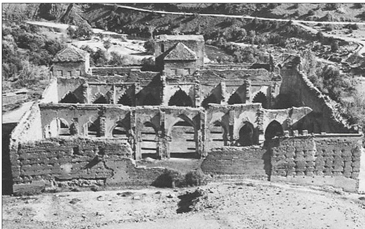
Fig. 51 : Vue du nord de l'édifice de Tinmel avant sa restauration de 1994 (Source internet : skyscrapercity.com)
