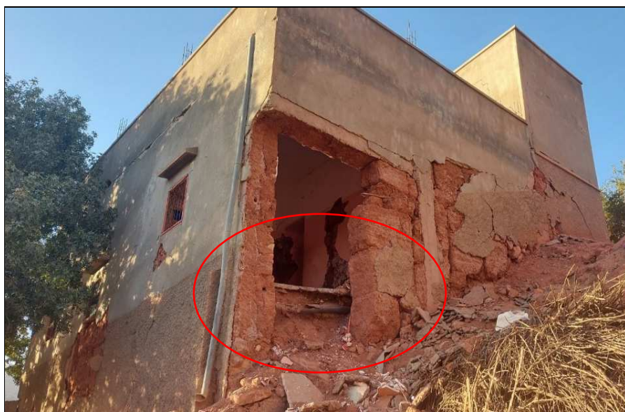
Fig. 30 : Exemple de bâtiment sans soubassement (Douar Asselda, Asni, Al Haouz)
