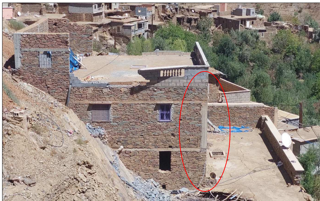
Fig. 27 : Eléments de renforcement-chaînage en béton armé appliqués sur des murs en maçonnerie traditionnelle de pierre (Douar Amchkrajen, Ighil, Al Haouz)
