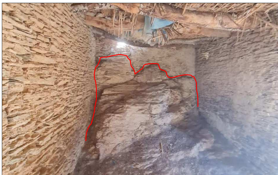
Fig. 31 : Exemple de murs implanté sur sol rocheux (Douar Assif Lmal, Chichaoua)
