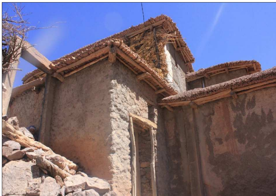
Fig. 46 : Exemple de planchers-toitures conçues avec des structures porteuses dans les deux directions (Douar Afella Nouzgrouz, Iguidi, Taroudant)
