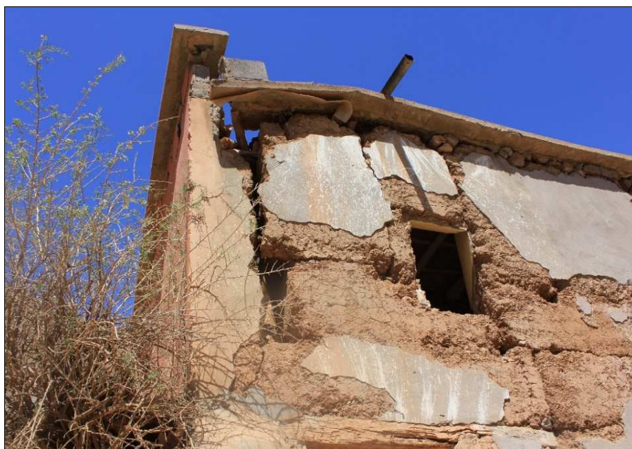
Fig. 35 : Exemple de pathologie de mur en pisé (Douar Ighfis, Tizi n'Tast, Taroudant)
