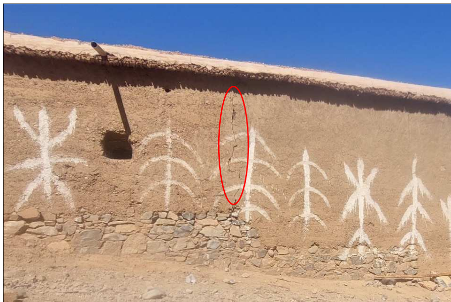
Fig. 33 : Exemple de mur de soubassement en gradin (Douar Aghllade, Iguidi, Taroudant)
