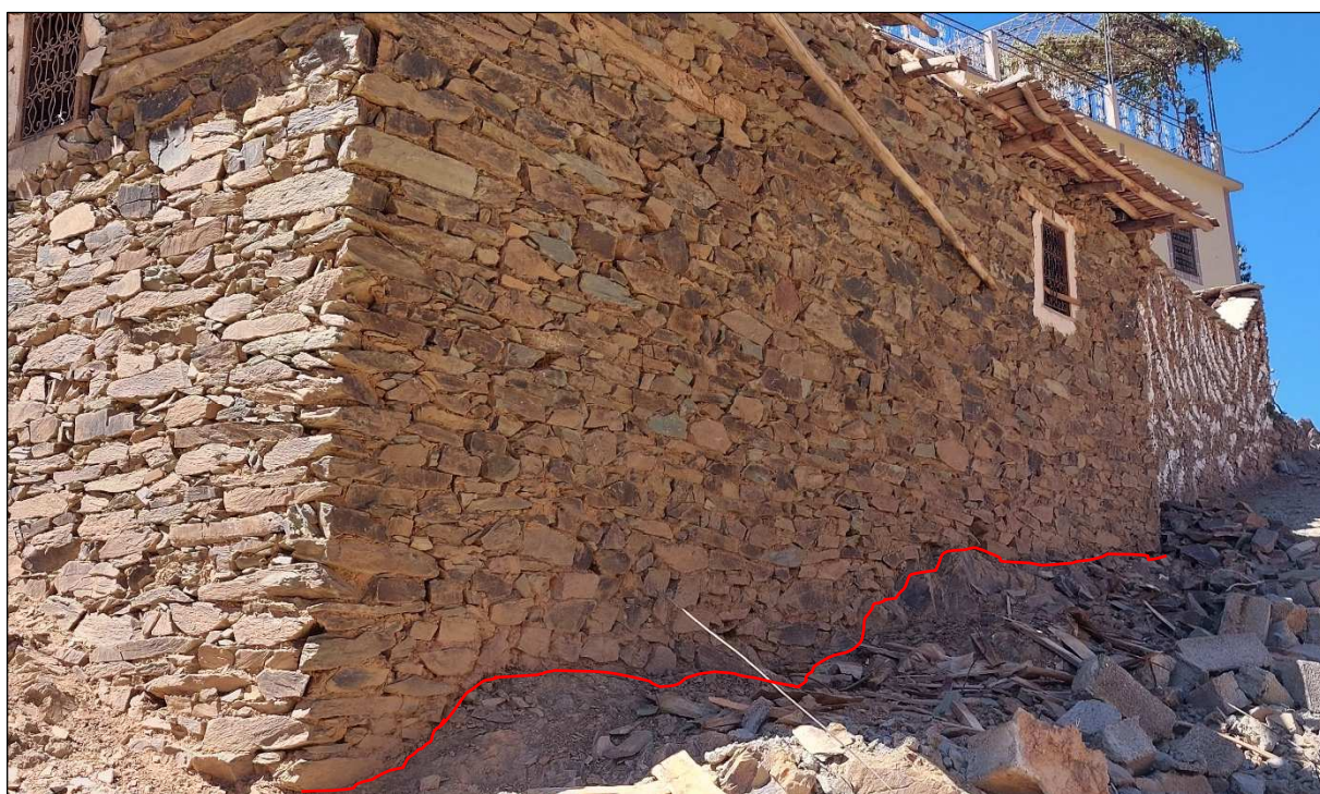
Fig. 23 : Exemple de constructions dont les murs porteurs sont simplement posés sur le terrain rocheux sans aucune disposition constructive particulière (Douar Amchrajen, Ighil, Al Haouz)
