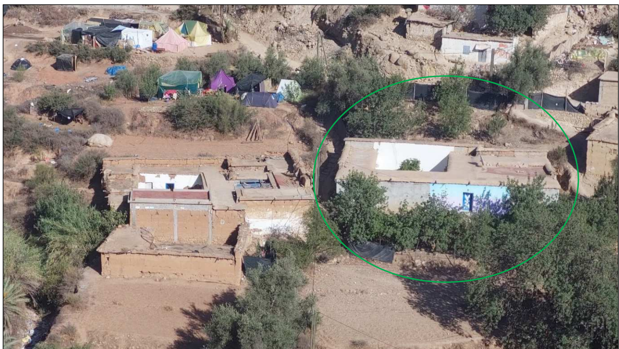
Fig. 15 : Effondrement total ou presque des anciennes constructions en terre implantées à la limite de terrasses non stabilisées (Douar Tajgalt, Tafingoult, Taroudant)
