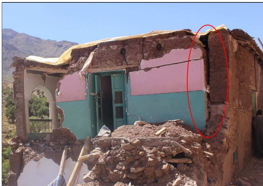
Fig. 36 : Exemple de pathologie liée à l'absence de dispositifs de liaison au niveau des jonctions des murs
