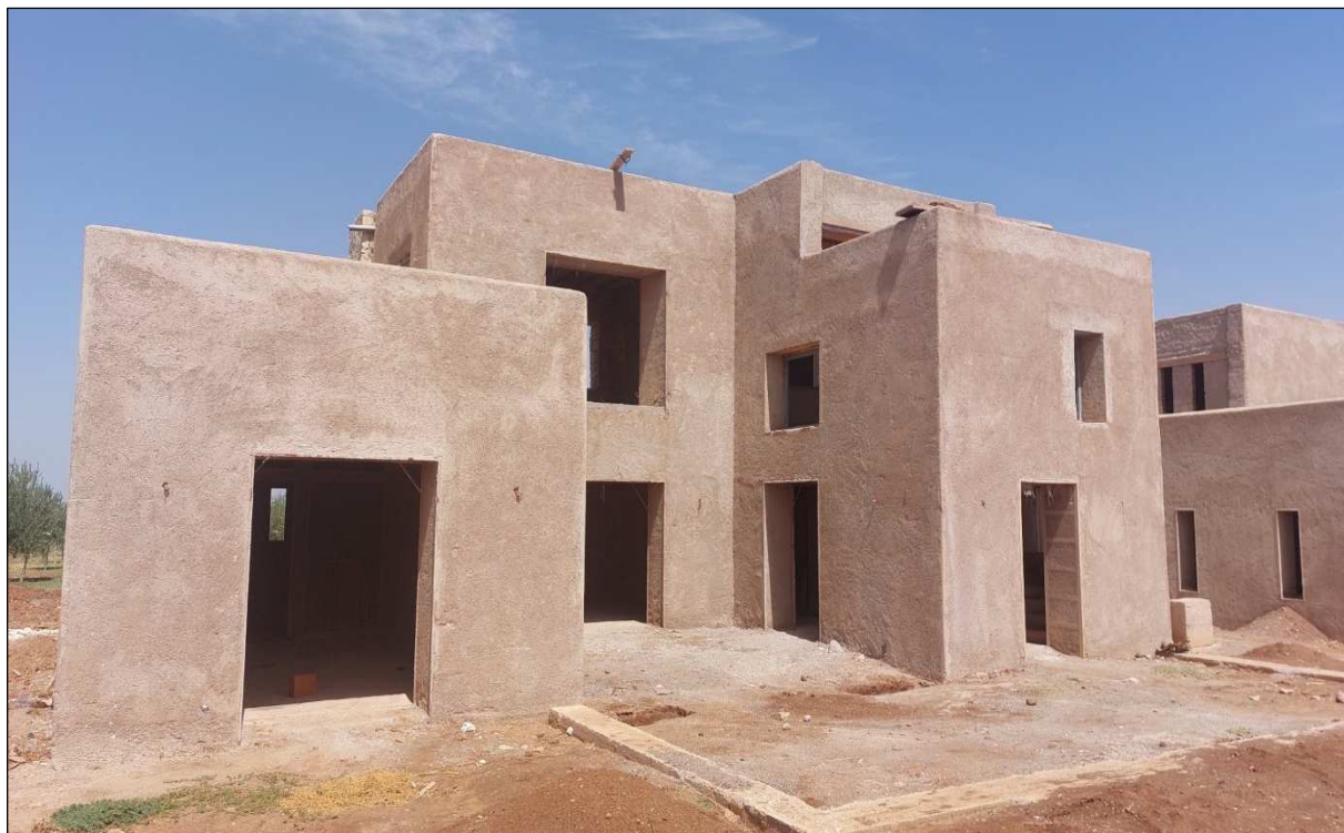
Fig. 50 : Construction en deux niveaux réalisés entièrement en maçonnerie en adobe
