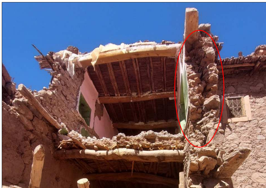
Fig. 37 : Pathologie typique des murs en maçonnerie de pierre liée à l'absence de boutisse de liaison des deux parois-faces des murs
