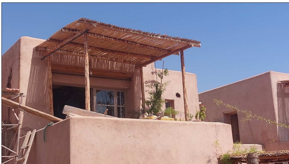
Fig. 48 : Les largeurs des ouvertures dans les nouvelles constructions dépassent parfois la limite recommandée
