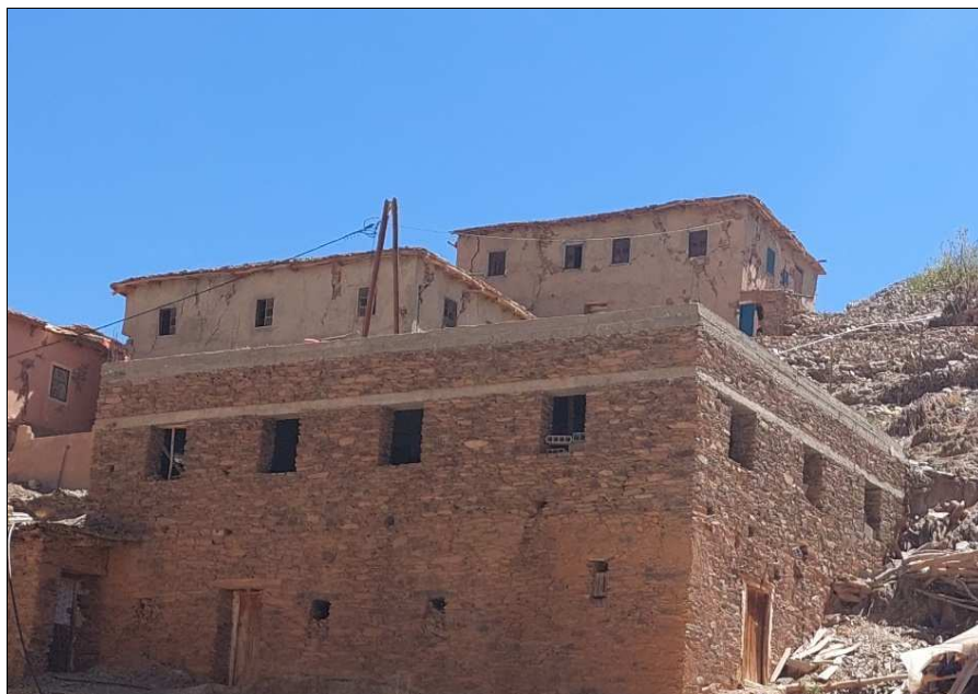
Fig. 42 : Continuité du linteau sur l'ensemble des ouvertures (Ighil centre, Al Haouz)
