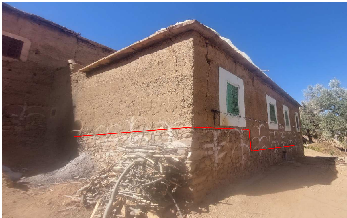
Fig. 22 : Soubassement en maçonnerie de pierre d'une construction en pisé (Douar Aghllade, Iguidi, Taroudant)
