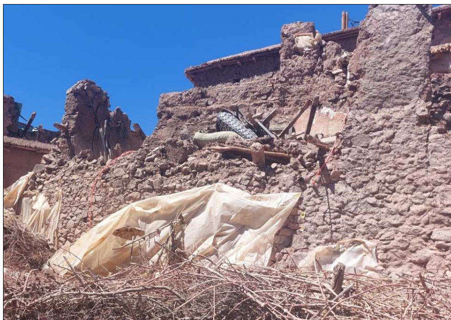
Fig. 38 : Irrégularité d'alignement caractéristique des très anciennes constructions (Douar Afella Nouzgrouz, Iguidi, Taroudant)
