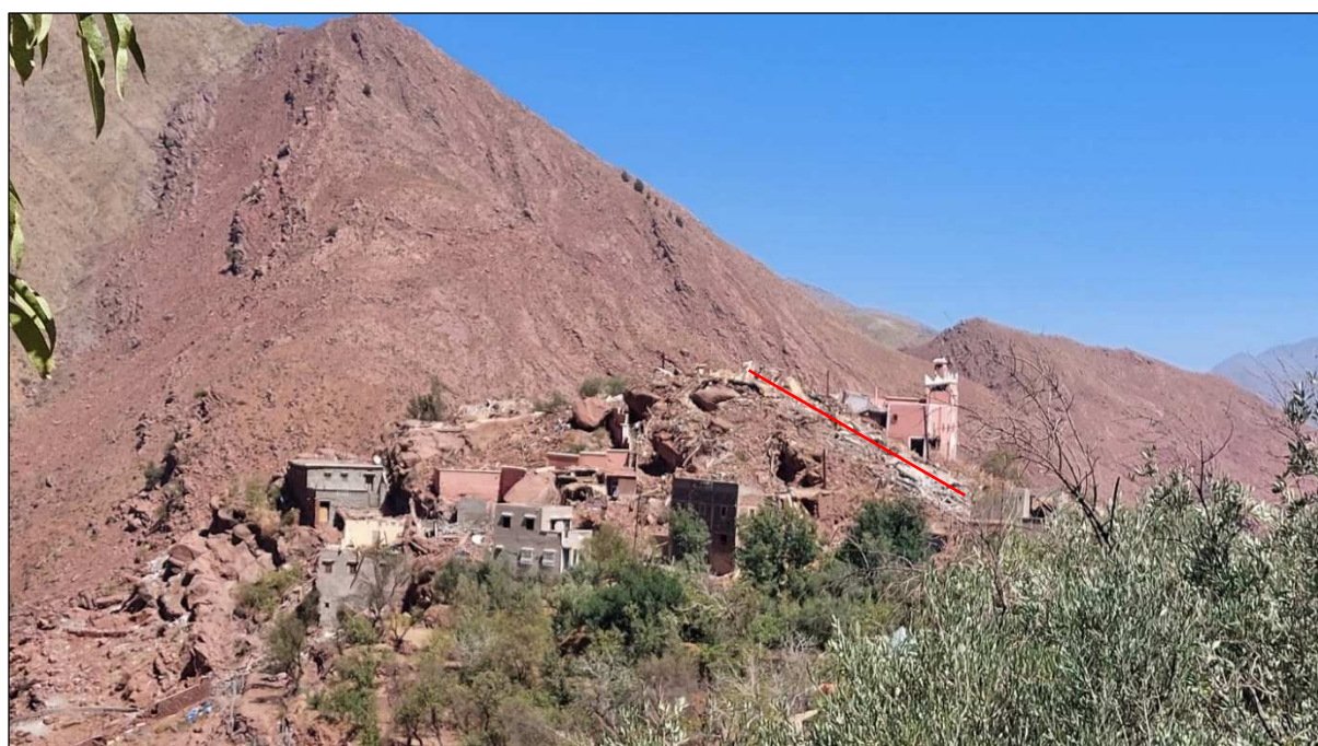
Fig. 16 : Effondrement total ou presque des anciennes constructions en pierre implantées sur pente rocheuse (Douar Amerzagane, Ighil, Al Haouz)
