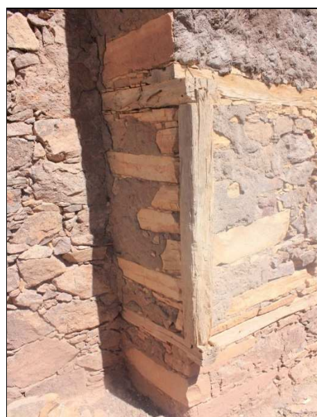
Fig. 26 : Technique de chaînage en bois massif local (Douar Afella Nouzgrouz, Iguidi, Taroudant)
