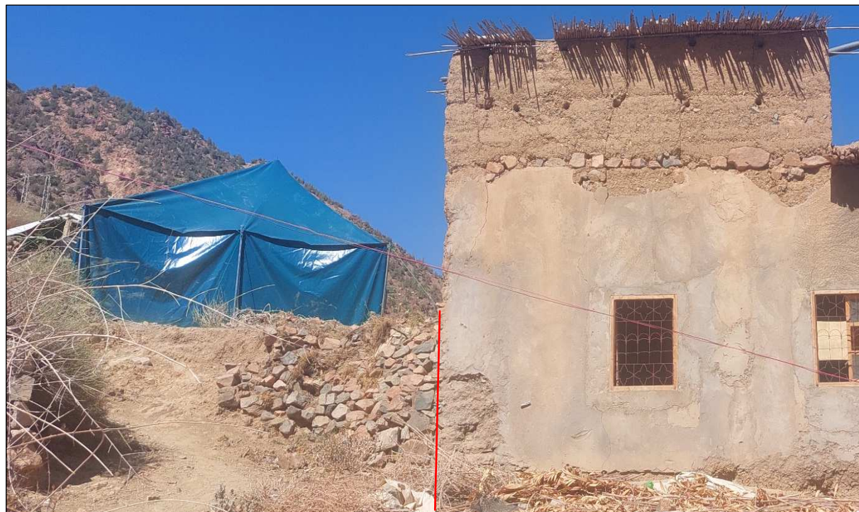
Fig. 24 : Exemple de mur extérieur exposé aux pressions des terres (douar Aghllade, Igudi, Taroudant)
