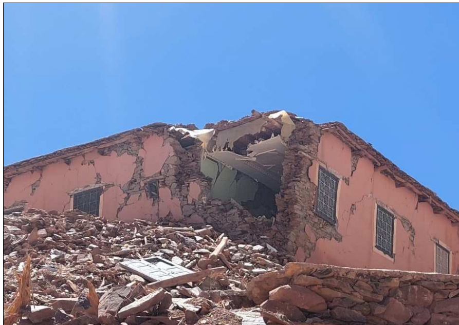
Fig. 44 : Effondrement d'un mur en maçonnerie de pierre dû à l'absence de chaînage de couronnement
