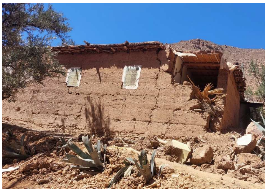
Fig. 45 : Effondrement d'un mur en pisé en l'absence de chaînage de couronnement (Douar Ighfis, Tizi n'Tast, Taroudant)
