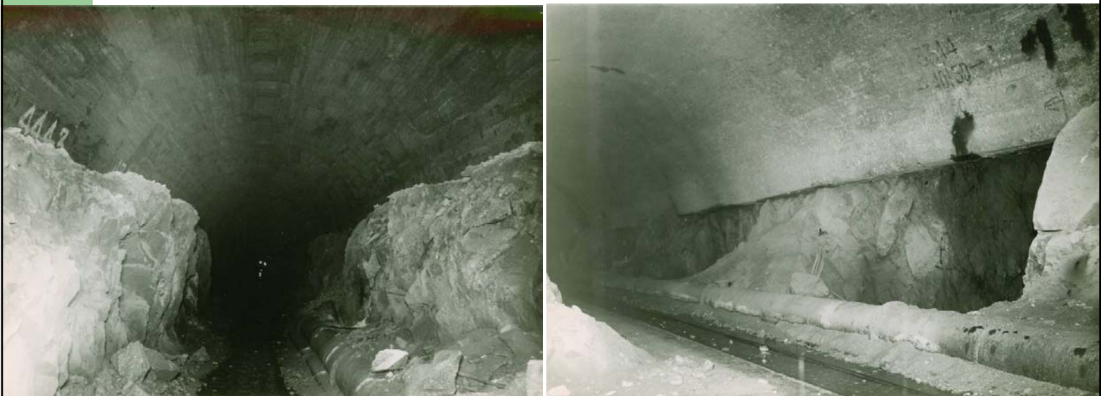
Terrassement du Stross Tunnel Maurice Lemaire (1934)
