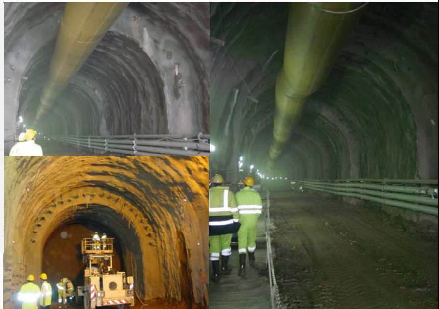
Voûtes Parapluies du Tunnel Maurice Lemaire
