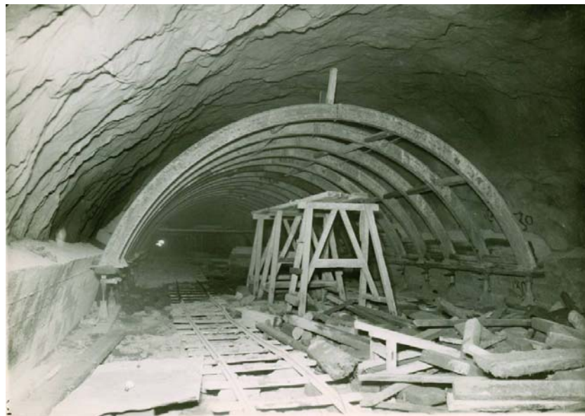
Réalisation de la voûte du Tunnel Maurice Lemaire (1934)
