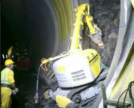
Niche Tunnel du Port de Dublin
