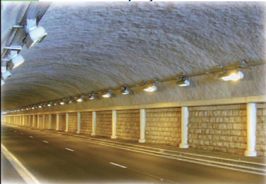
Tunnel de Sisteron
