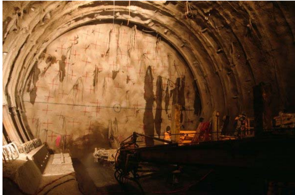
Front du Tunnel de Tartaiguille Cours de Travaux Souterrains
