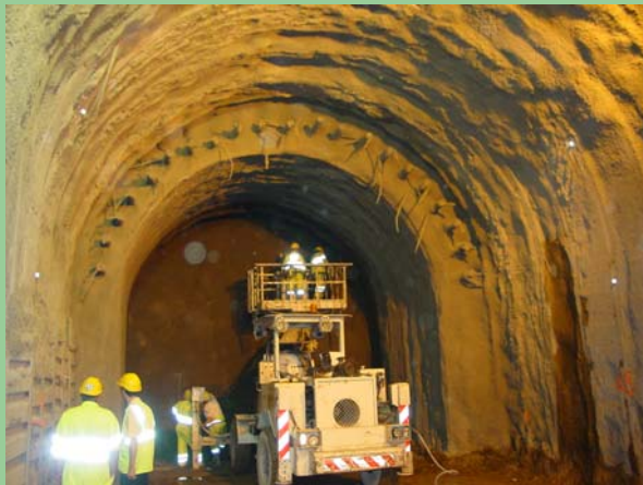
Tunnel Maurice Lemaire - Galerie de Sécurité
