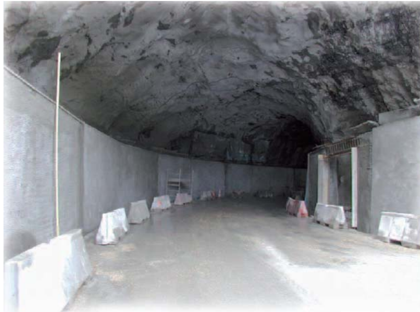
Tunnel des Aravis
