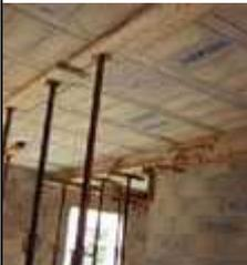
Plancher hourdis en béton
