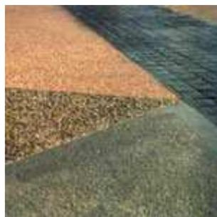
La couleur "naturelle" du béton est déterminée par ses composants. Cette couleur peut être nuancée par l'ajout de colorants, dosés avec précision et ajoutés dans le malaxeur au moment de la fabrication du béton en centrale à béton, pour obtenir un mélange homogène et une teinte dans la masse du béton. La durabilité de la couleur du béton est ainsi garantie sur plusieurs décennies.
