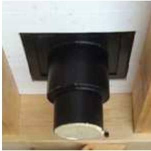
*Les conduits raccordés sur les cheminées démarrent très souvent au plafond pour des raisons de commodité. La solution à privilégier dépend de certains critères tels que le type de cheminée, la position du conduit, la nature du plafond, la structure de la charpente ... On peut classer ces solutions en deux grandes familles qui sont les conduits maçonnés et les conduits non maçonnés.*
