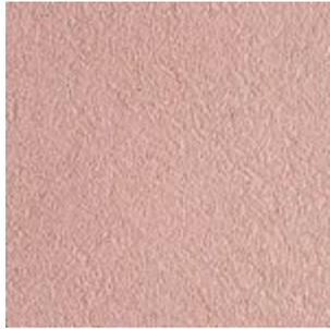
**Le taloché** : l'enduit est plus ou moins lisse et fermé selon la taloche employée. Plus lisse dans le nord que dans le sud où l'on emploie le terme de "frottassé" pour un aspect plus traditionnel. La teinte choisie avec ce type d'aspect peut au final paraître plus claire car le talochage de l'enduit a légèrement tendance à éclaircir les teintes.
