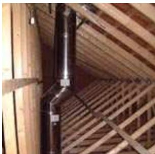
Ces conduits sont montés par emboîtement et serrage d'éléments modulaires entre eux. Ce type de montage est dit à sec.
