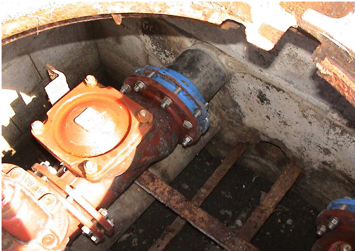
Schéma de montage d'un clapet anti-retour
