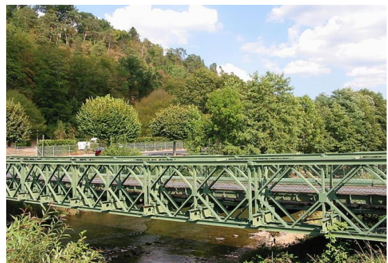
Pont Bailey sur la Meurthe, France. Pont provisoire en treillis, permettant une mise en place très rapide
