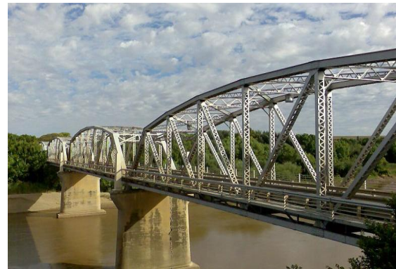
Pont à quatre travées à treillis traversé du pont du Général Hertzog sur le fleuve Orange à Aliwal North.
