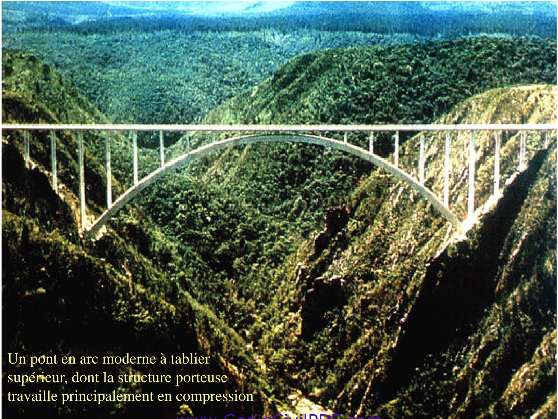
Un pont en arc moderne à tablier supérieur, dont la structure porteuse travaille principalement en compression
