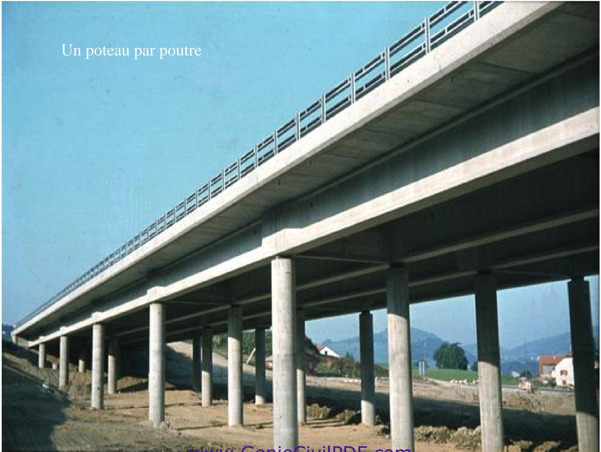
Schéma de principe d'une pile avec chevêtre supportant les poutres
