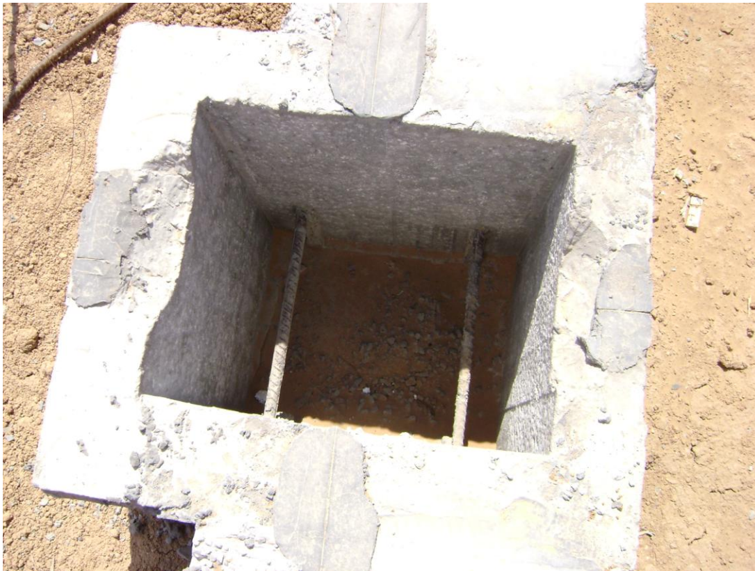
Traçage des axes longitudinaux et transversaux & Clés d'ancrage anti-
