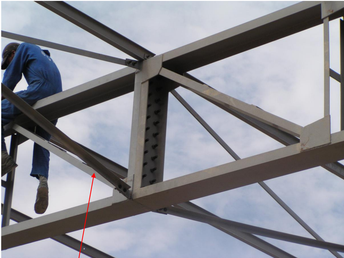
Montage des ciseaux longitudinaux
