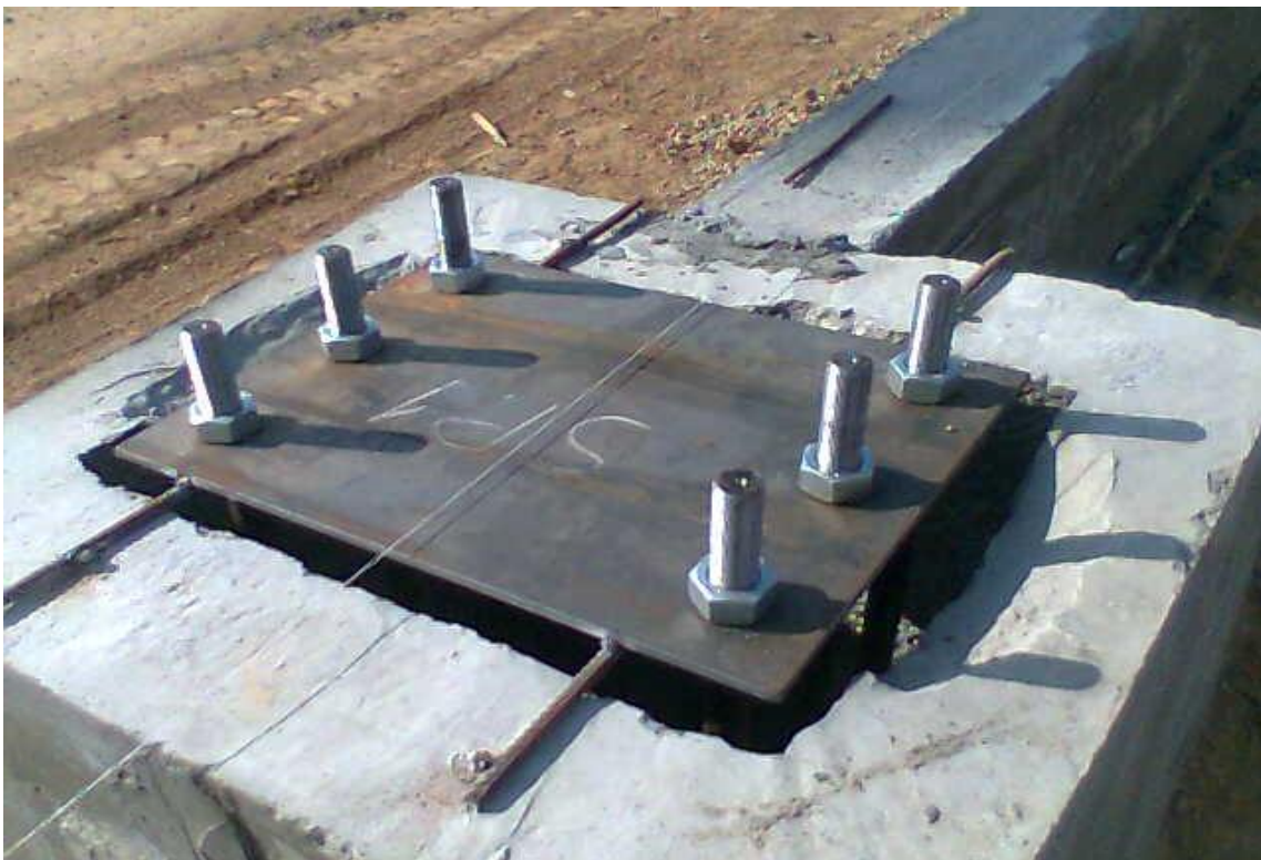
Mise à niveau des platines
