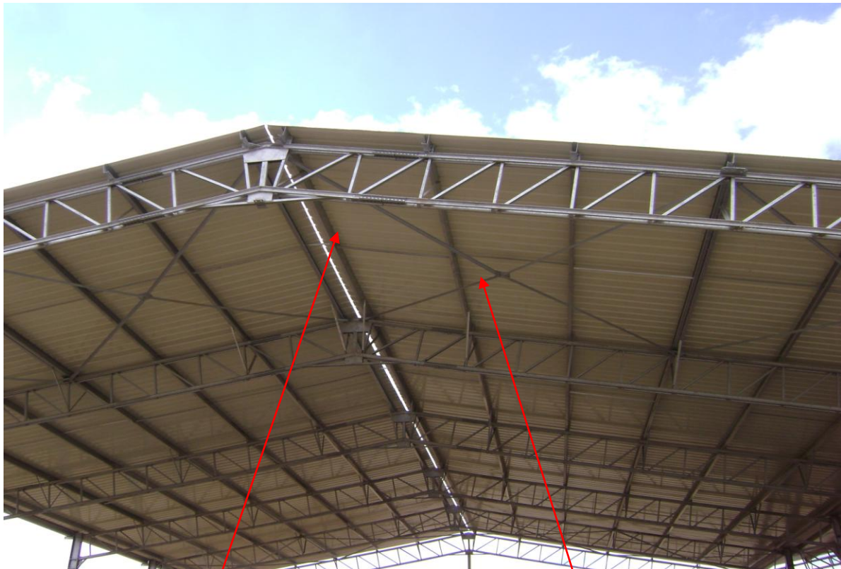
Montage de la couverture en tôle ondulé
