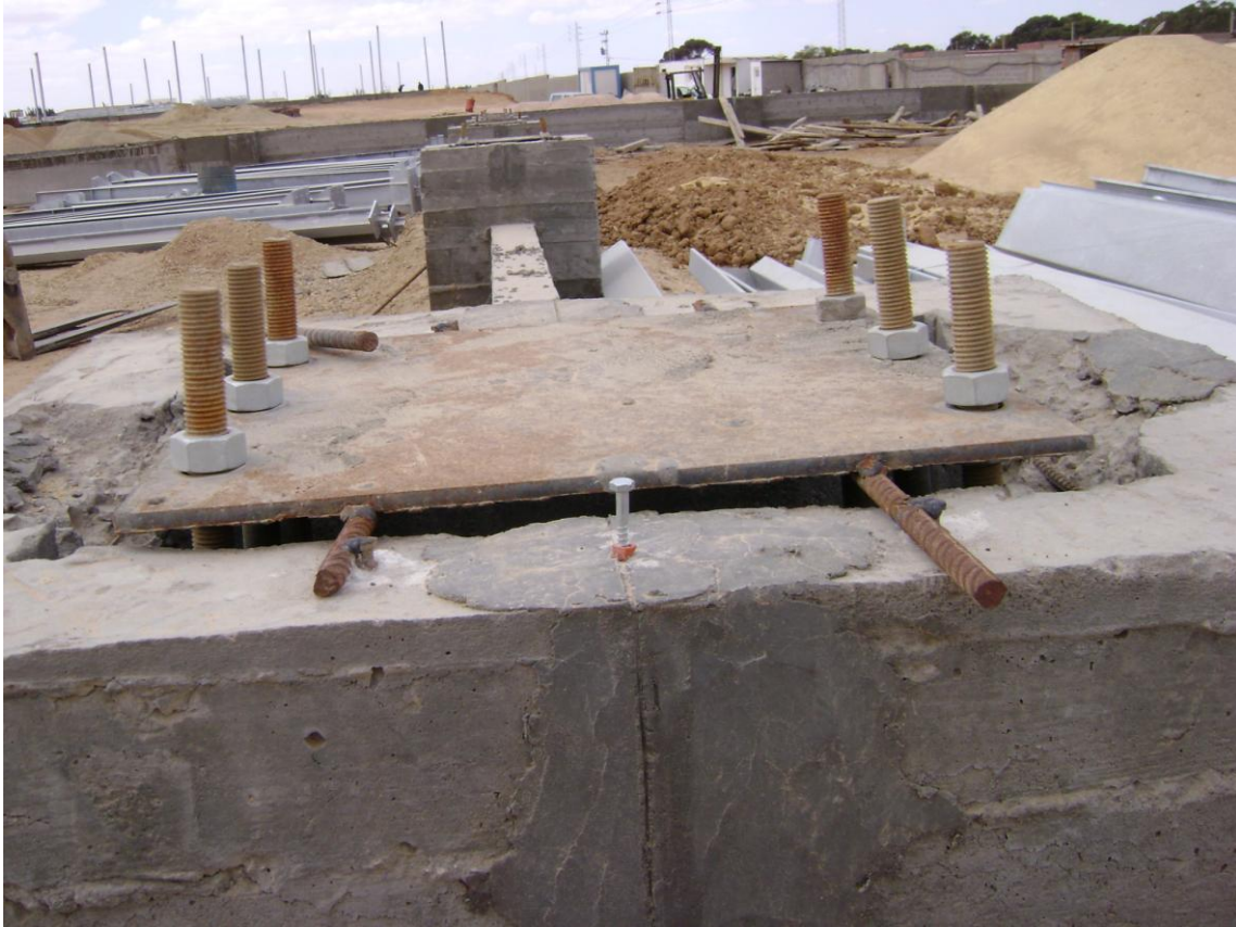
Alignements longitudinal et transversal
