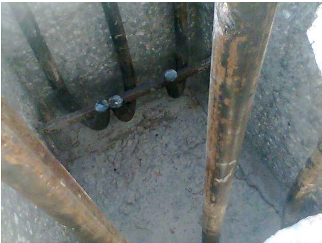
Mise en place des crochets à bouts filetés
