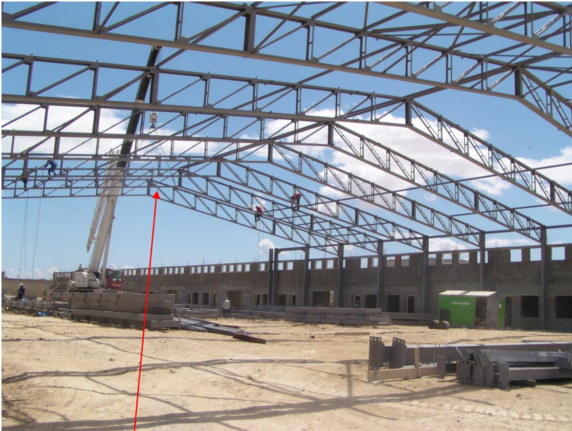
Montage de la ferme positionnement avec la grue
