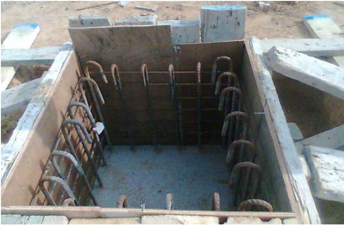
Coffrage et ferrailage du fût
