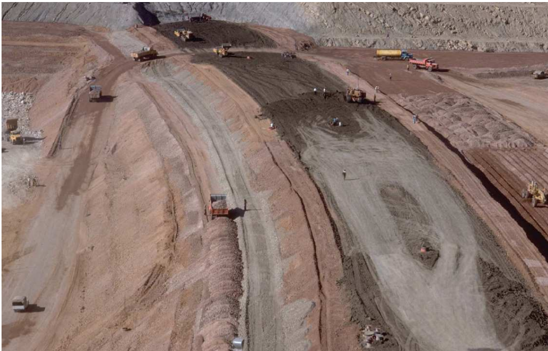
Figure 14: exemple de chantier de barrages à noyau
