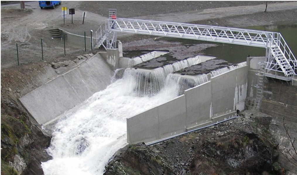
Figure 46 : exemple de déversoir en touches de piano (Barrage de GOULOURS, France)
