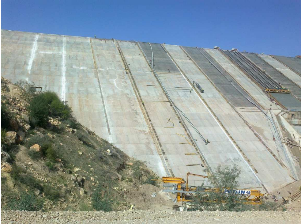
Figure 19: vue de l'amont du masque amont en béton du barrage Zerrar en cours
