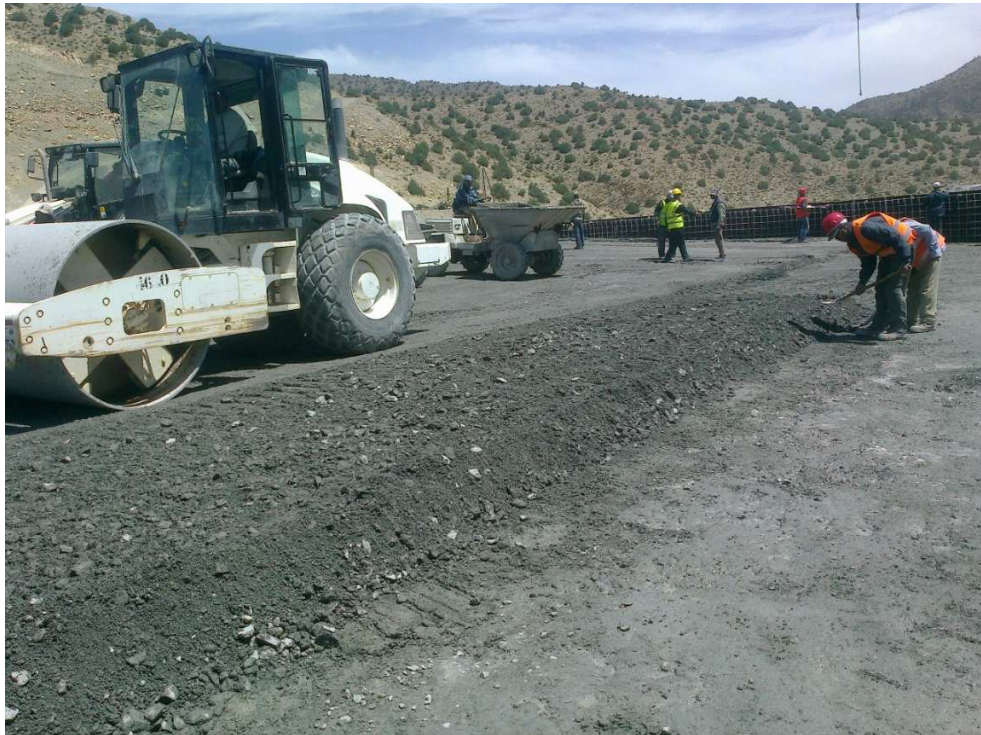
Figure 9: exemple de chantier de barrage poids en BCR (barrage Tamalout)
