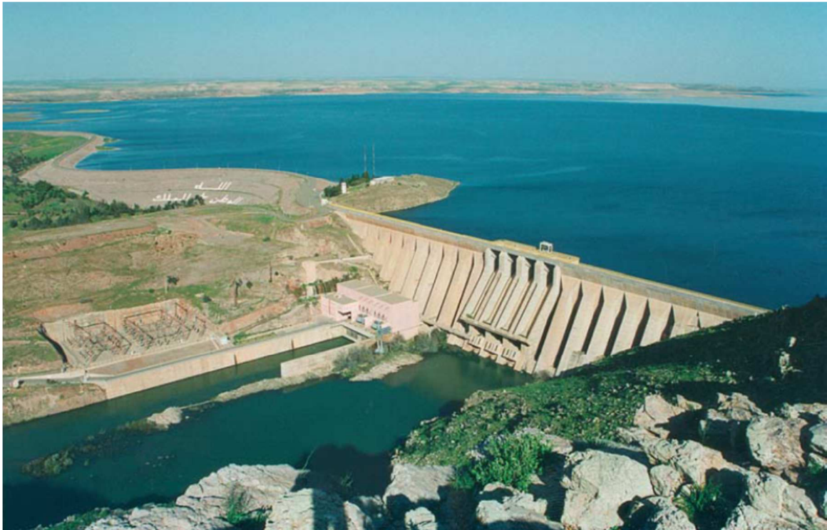
Figure 8: exemple de barrage à contreforts (Al Massira)
