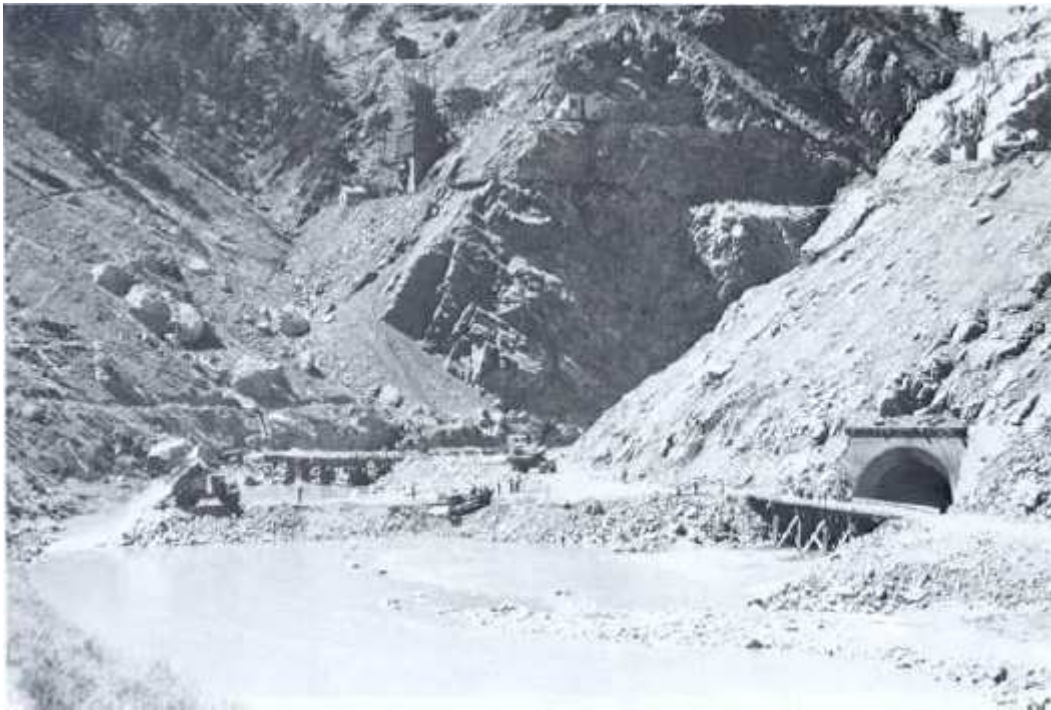
Figure 70: dérivation provisoire avec un tunnel
