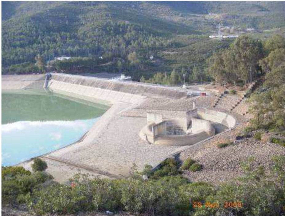
Figure 35: EVC en tulipe cas du barrage Nakhla
