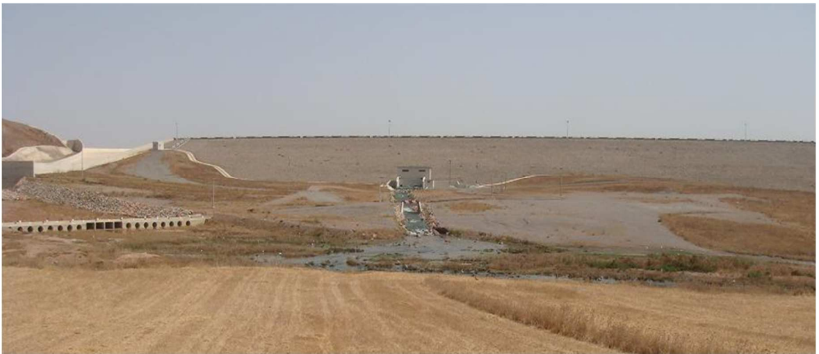
Figure 15 : exemple d'un barrage zoné à noyau (Barrage El Himer)
