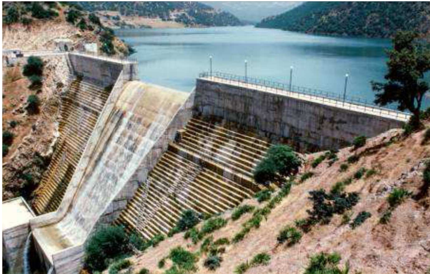
Figure 33: EVC pour un barrage rigide placé en partie centrale (barrage Bab Louta)
