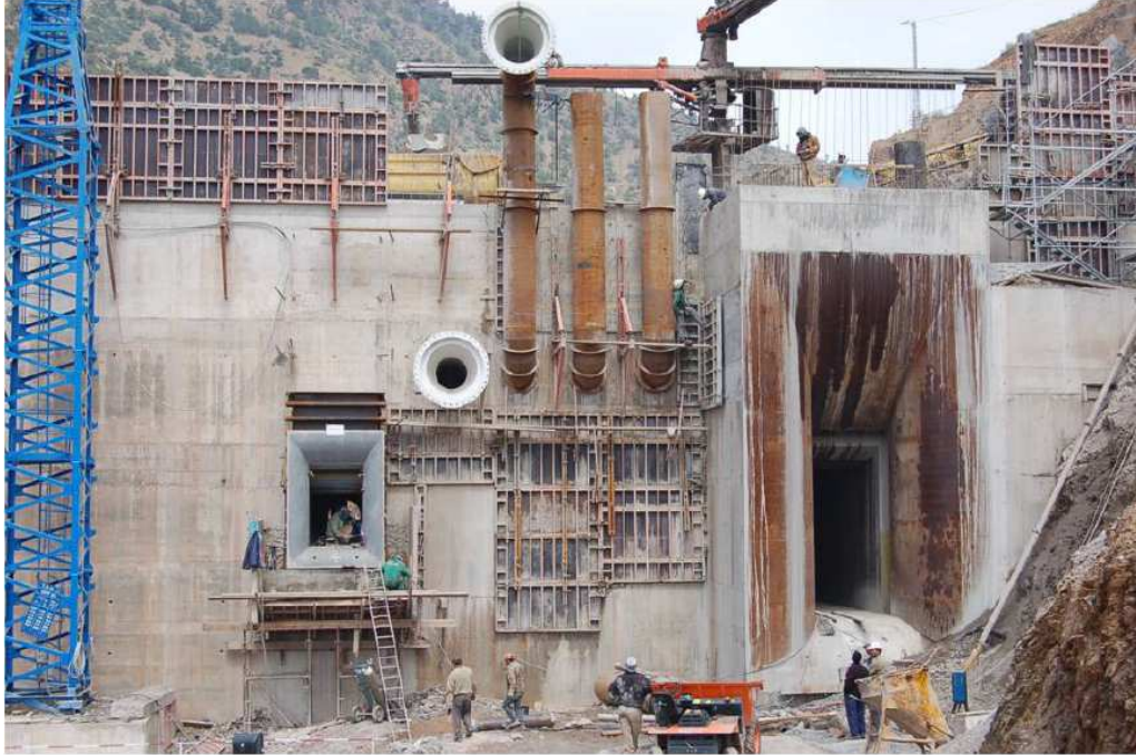
Figure 26: exemples d'ouvrages annexes permettant les utilisations du barrage (barrage Wirgane)
