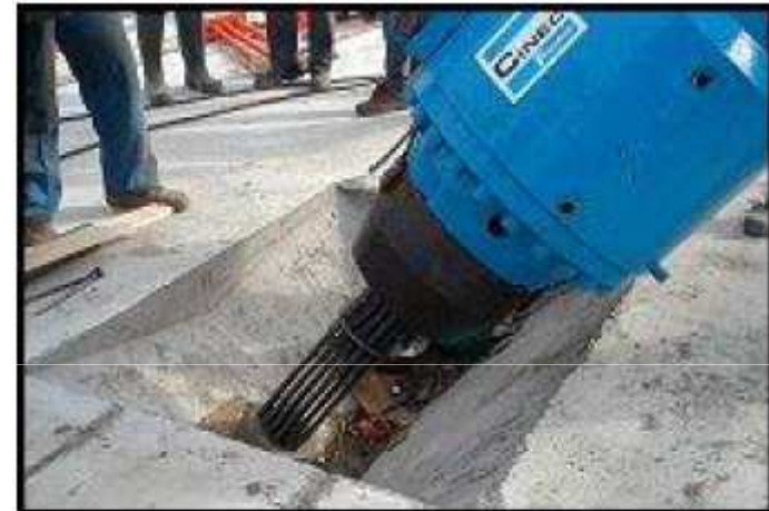
Mise en tension des câbles
