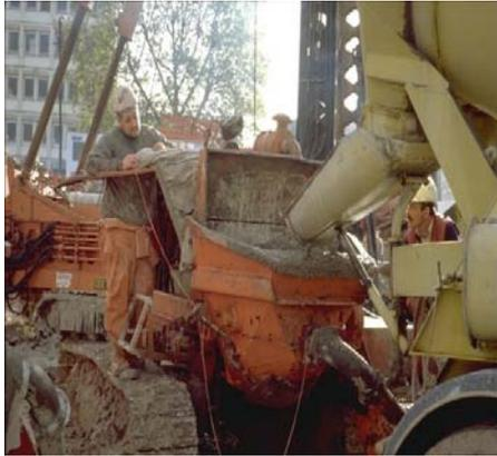
Le béton est livré par la toupie dans la pompe à béton
