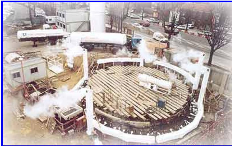
L'augmentation de volume de l'eau lors de sa transformation en glace peut provoquer des désordres dans le voisinage de la zone traitée et doit être prise en compte lors de l'élaboration du projet de traitement.
