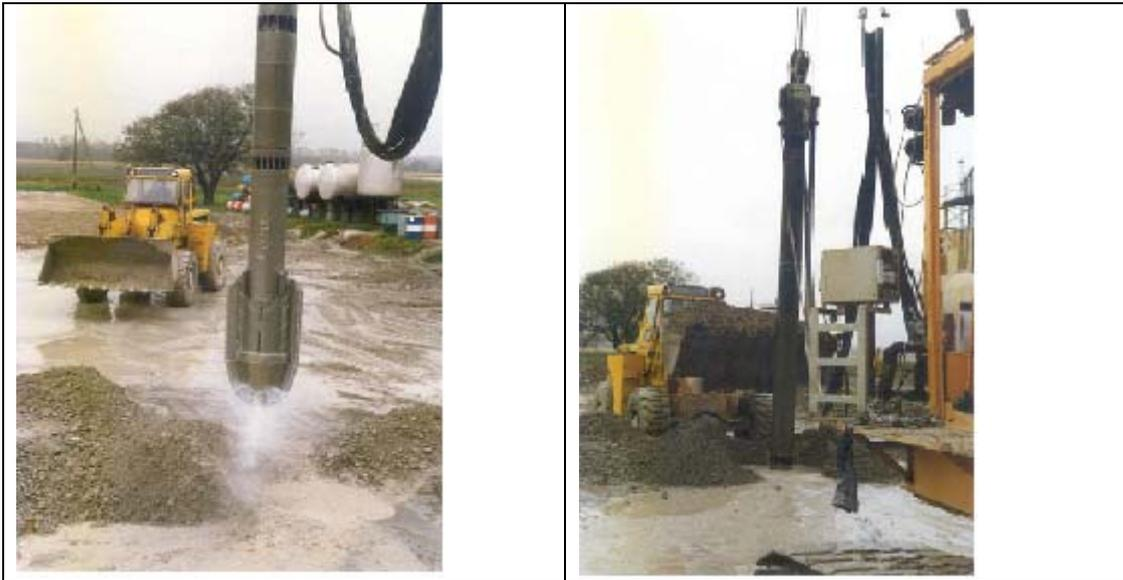
**Phase 3 :** Le vibreur est retiré par étapes et produit de cette manière un cylindre de terrain densifié de 2 à 4 mètres de diamètre.
