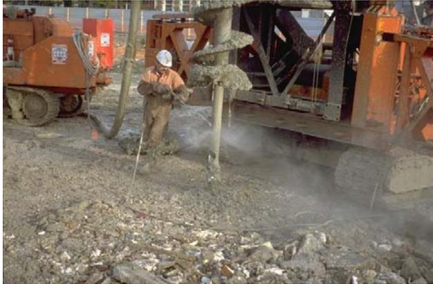
On nettoie le tube plongeur avant nouvelle utilisation
