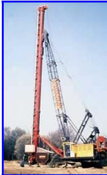
Le drainage vertical est une technique complémentaire des techniques de préchargements. Il permet une consolidation plus rapide du sol.
