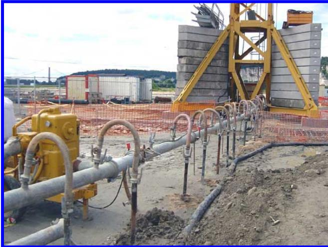
On réalise des drainages par pompage dans des rangées de puits filtrants.
